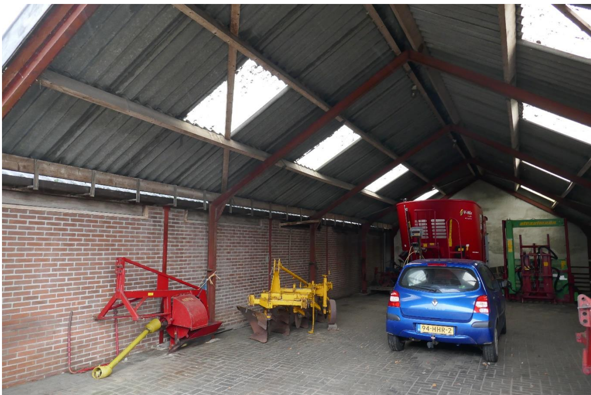
Object 2. Garage, loods opslag machines.
