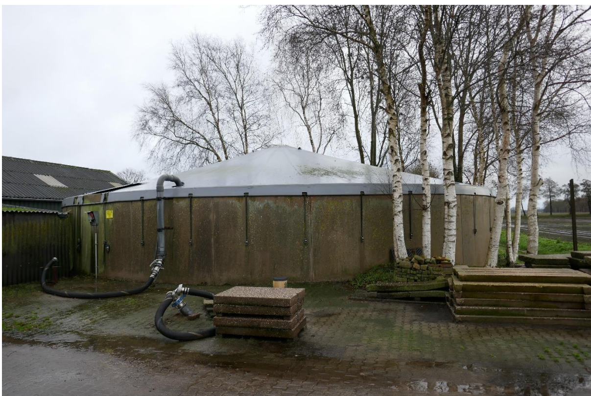
Object 4. Mestsilo. Hier zullen enkele berken worden gekapt t.b.v. sloop silo.
