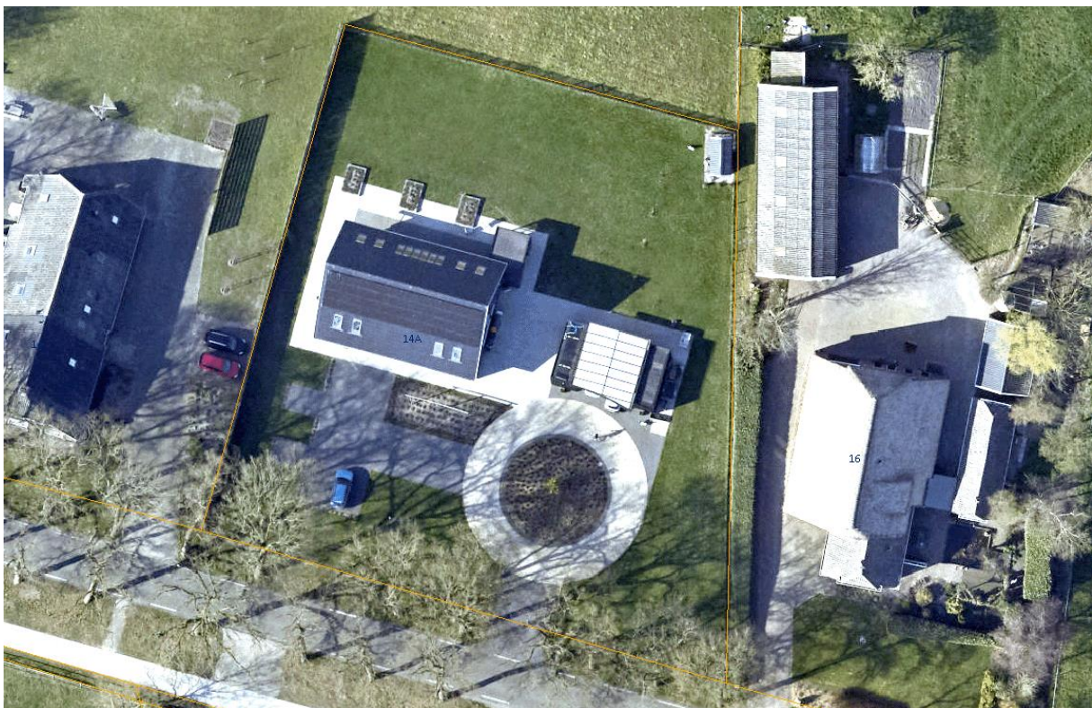
Figuur 2. Luchtfoto Beilerstraat 14A te Westerbork
