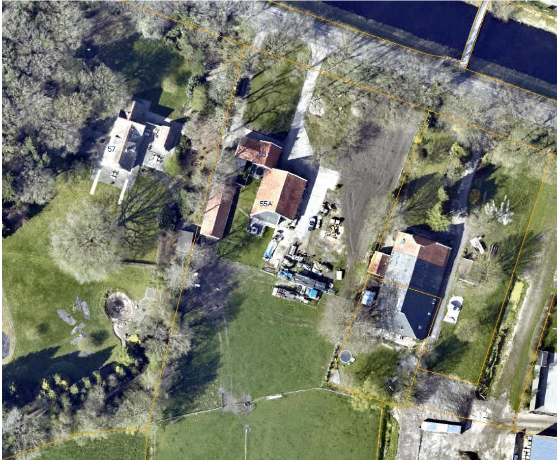
Figuur 2. Luchtfoto Oranjekanaal Z.Z. 55 te Hijken
