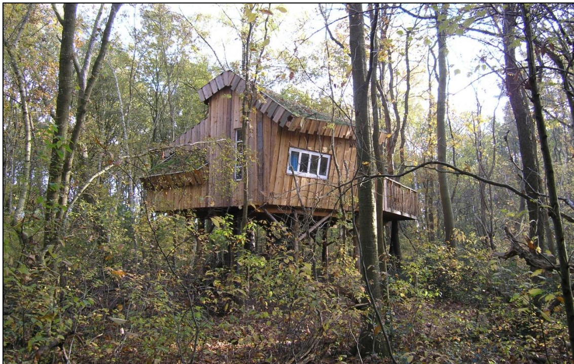
Figuur 3. Bestaande boomhut (6 november 2018)
