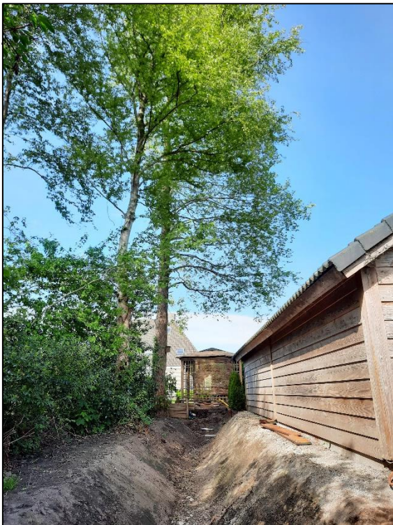
Figuur 5. Greppel bij boom 1 en 2. Diepte van de greppel is circa 0,7 tot 0,65 m -mv.
