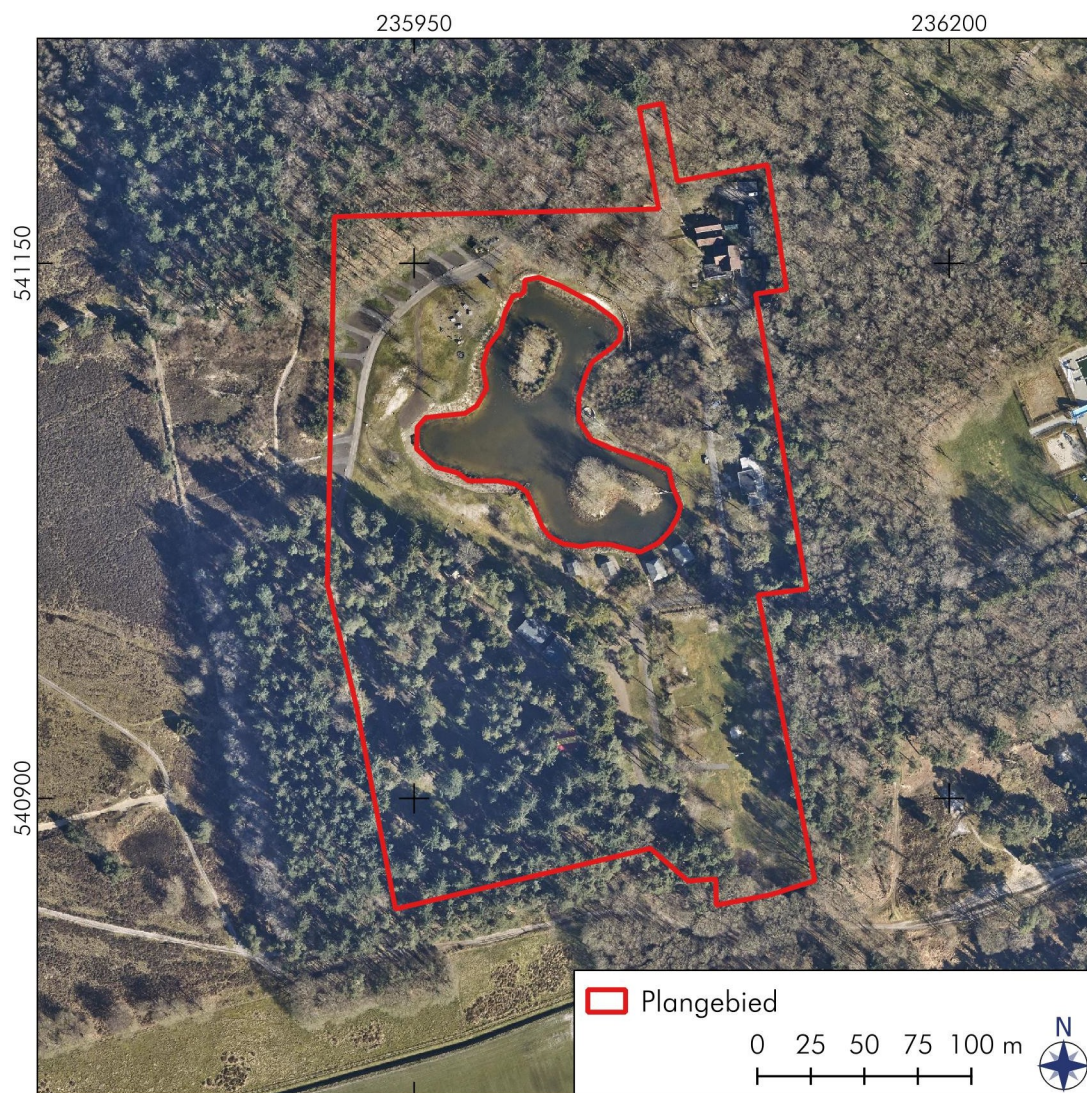
Figuur 2. Westerbork, Beilerstraat 13a: Luchtfoto van het plangebied.
