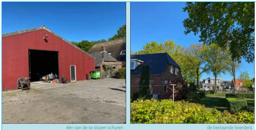
één van de te slopen schuren
