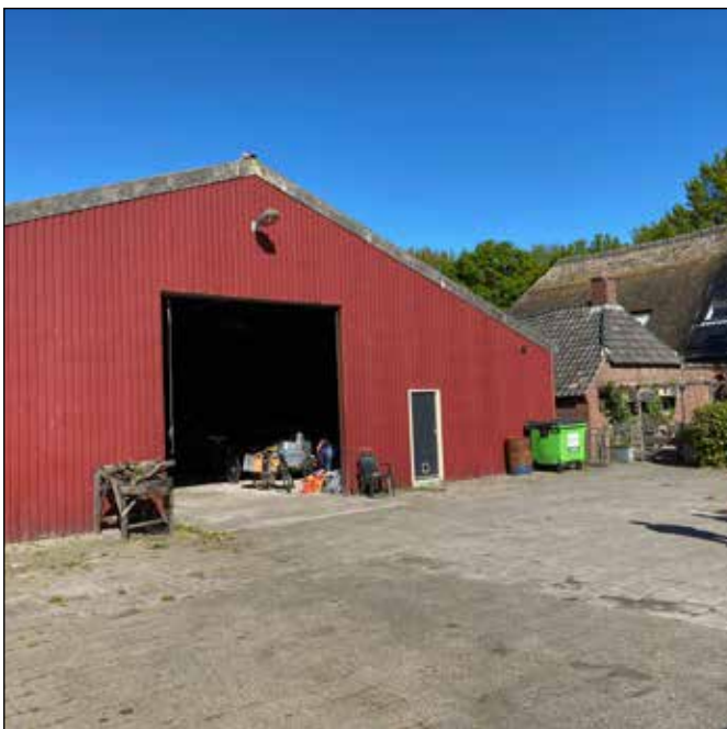
één van de te slopen schuren
