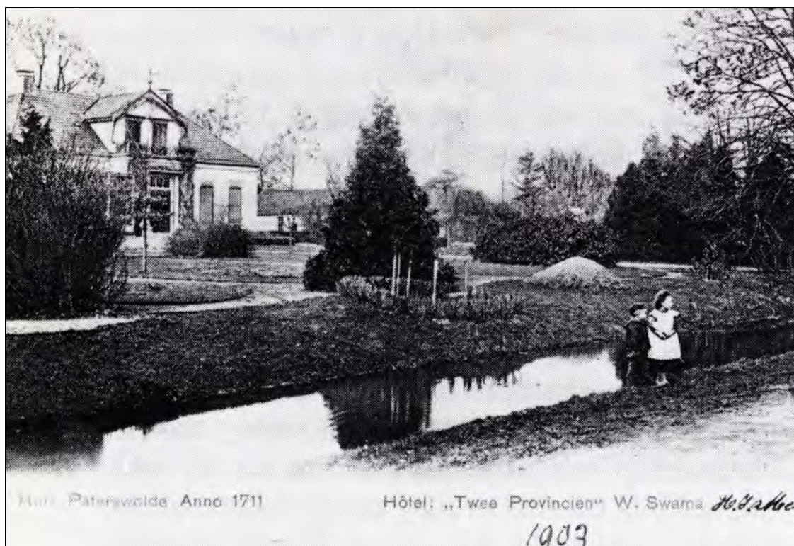
Figuur 2.29 Huis Paterswolde in het begin van de twintigste eeuw. 292
