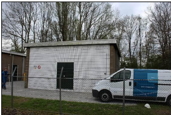
figuur 3.20. Mod. 9, renovatie GOS N254 Paterswolde
