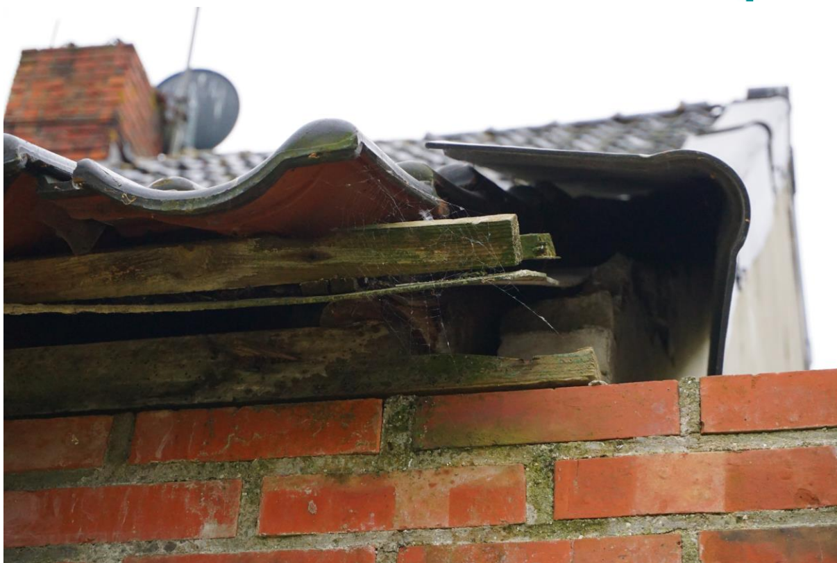
Figuur 4.6 Aan de rand van het dak zijn voor vleermuizen geschikte openingen aanwezig.
