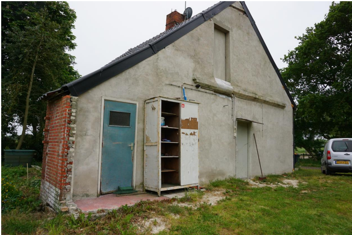
Figuur 4.3 De kantpannen van de westelijke kopgevel zijn afgesloten met een kunststof plaat.
