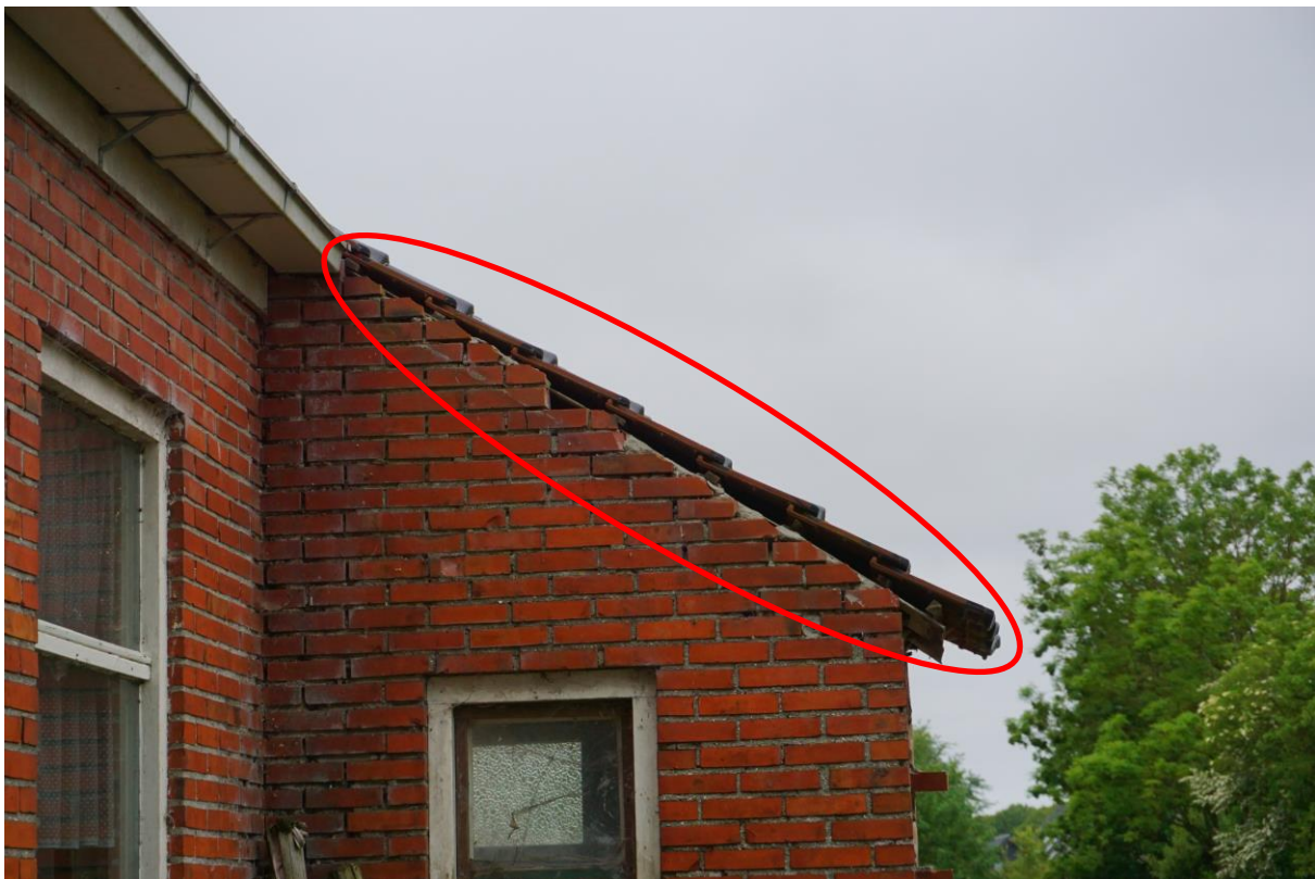
Figuur 4.5 Aan de rand van het dak zijn voor vleermuizen geschikte openingen aanwezig.
