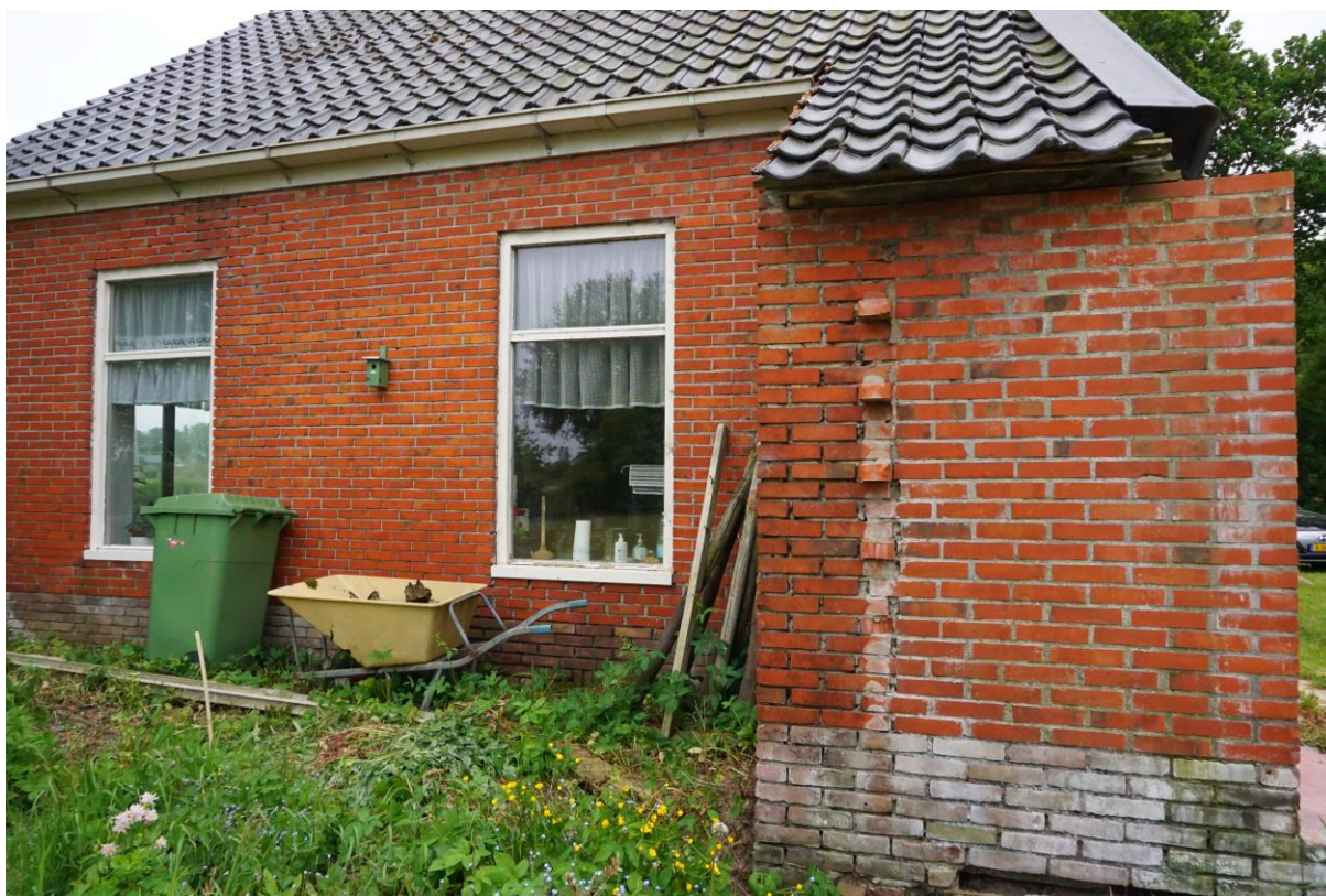
Figuur 1.4 Noordelijke gevel van de woning.
