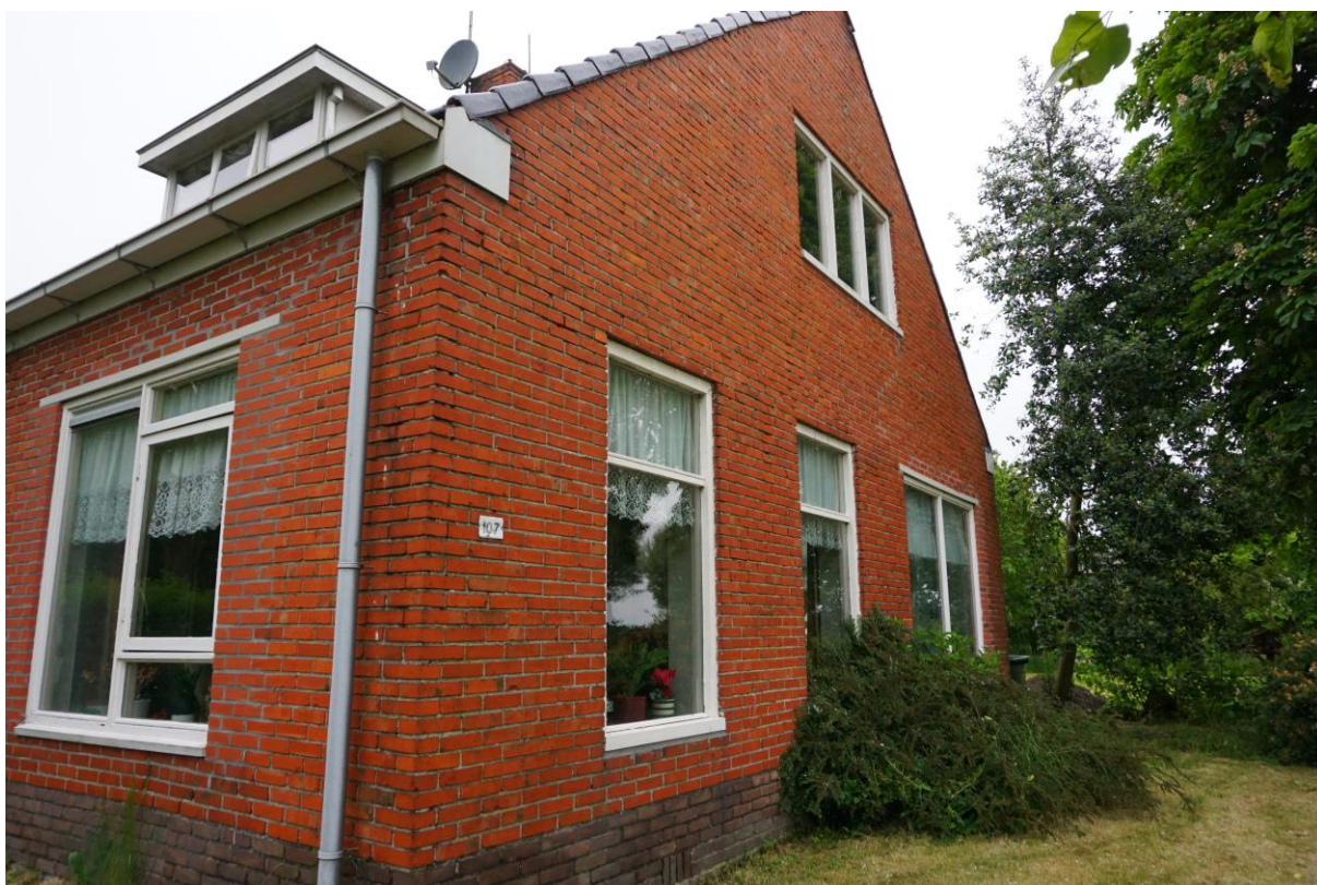
Figuur 1.2 Oostelijke gevel van de woning.
