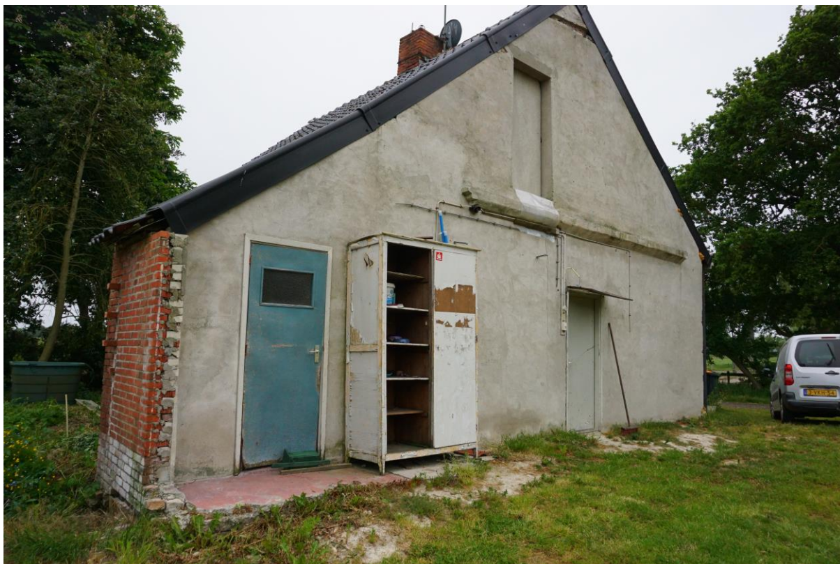
Figuur 1.3 Westelijke gevel van de woning.
