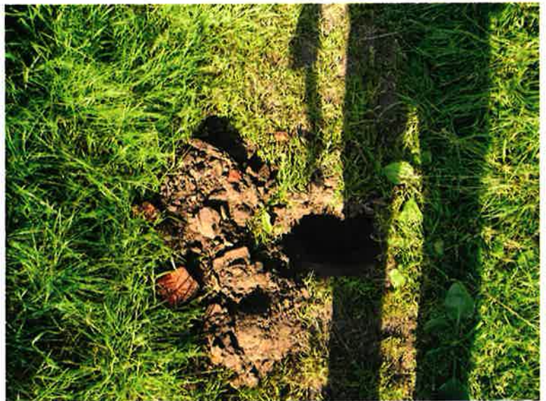
Detailfoto puinhoudende dam 3 (foto 8)
