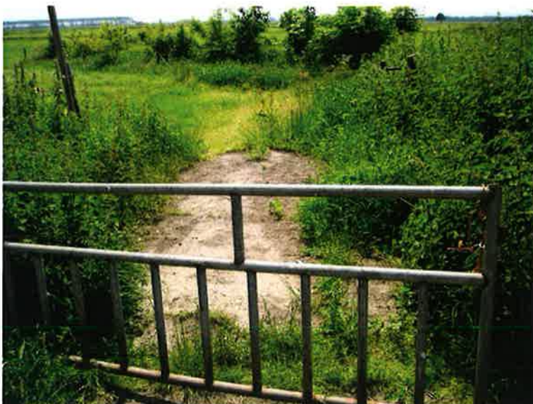
Overzichtsfoto dam (11) met betonverharding (foto 31)
