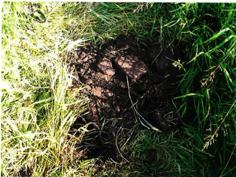
Detailfoto puinhoudende dam 4 (foto 10)
