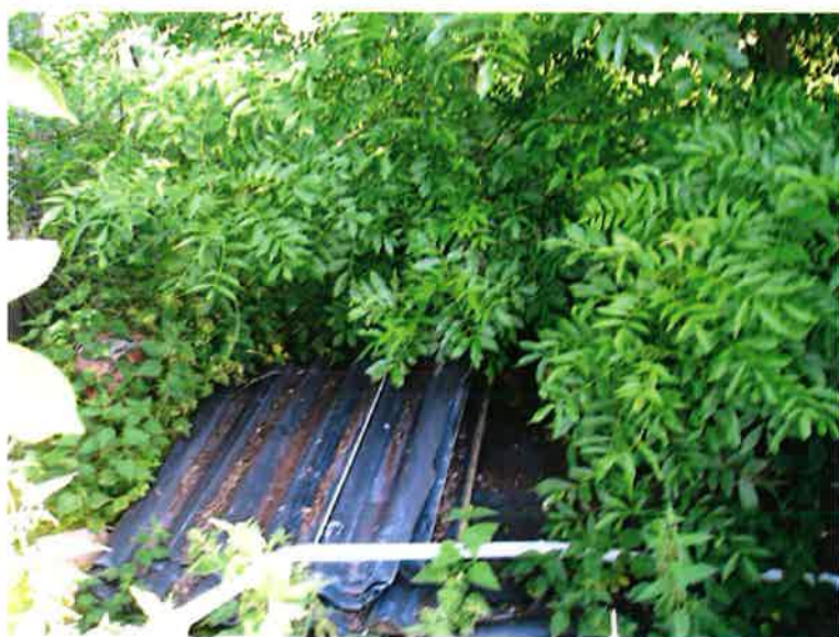
Opslag van asbestverdachte dakplaten aan de westkant van het perceel (foto 18)
