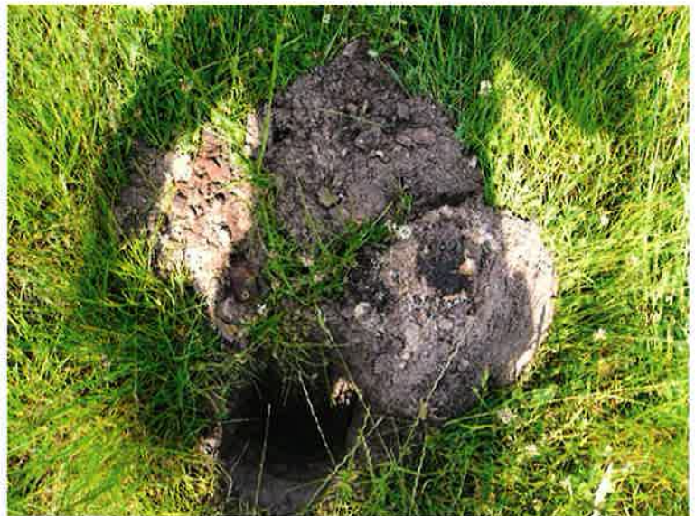
Detailfoto puinhoudende dam 10 (foto 21)
