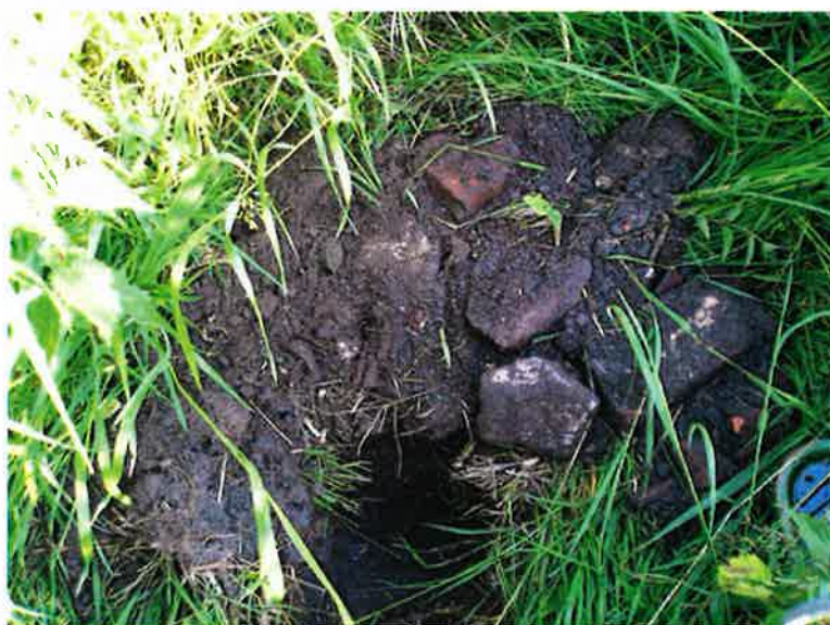
Detailfoto puinhoudende dam 1 (foto 4)
