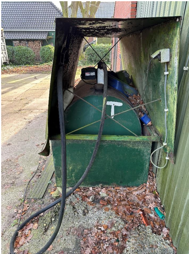
Afbeelding 6. Bovengrondse gasolietank gelegen aan de oostzijde van de (opslag)schuur/werkplaats.
