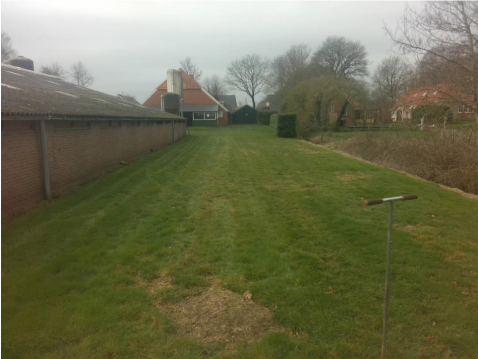
Afbeelding 4. Veestal met asbestgolfplaten noordzijde met dakgoten.
