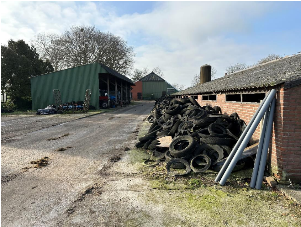
Afbeelding 3. Overzicht van de onderzoekslocatie met rechts de veestal aan de zuidzijde zonder dakgoten met betonverharding op het maaiveld.
