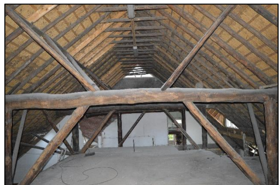
Afbeelding 2.4. Binnenzijde dak van de boerderij.
