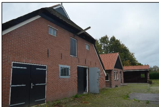
Afbeelding 2.3. Achterzijde boerderij en woning.
