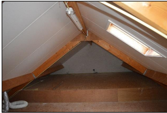
Afbeelding 2.7. Zolder aangebouwde woning.
