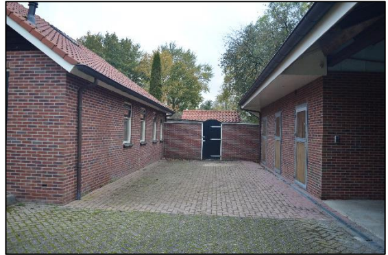
Afbeelding 2.12. Aangebouwde woning (links) met stallen (rechts)
