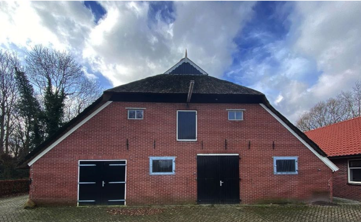
Opnieuw gemetselde achtergevel
