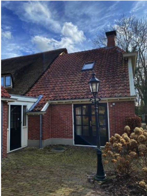
De openslaande deuren zijn later geplaatst.
