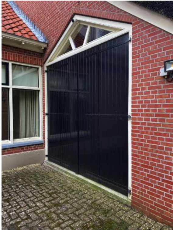
Schuurdeuren aan de voorzijde. De schuur is opnieuw gemetseld.
