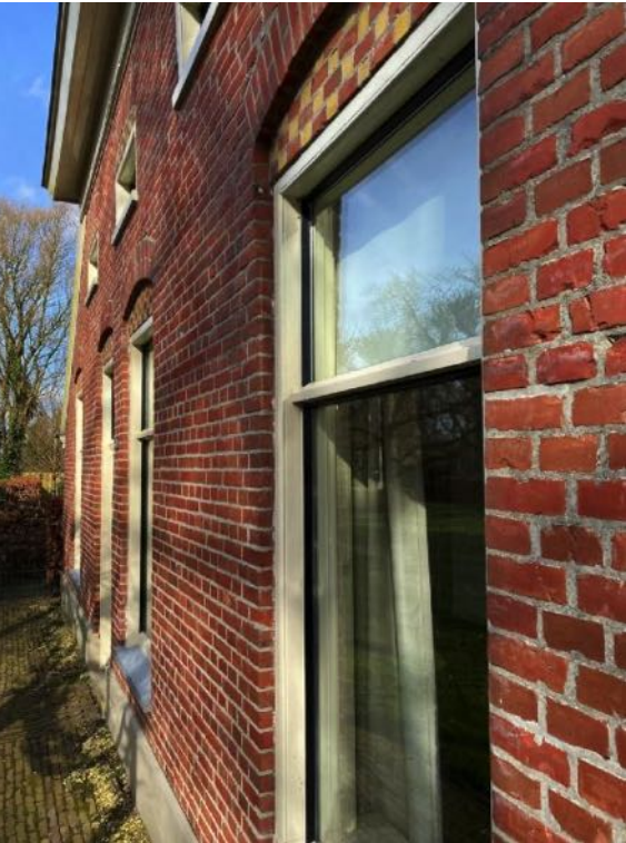
De voorgevel is (vlak) gevoegd en voorzien van extra detaillering boven de ramen ten opzichte van de oorspronkelijke situatie
