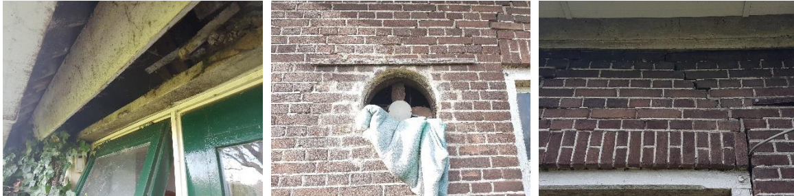
Figuur 7 Voorbeelden van plekken aan de woonboerderij waar vleermuizen naar binnen kunnen om er een al dan niet vaste rust- of verblijfplaats te vinden. Links: kieren tussen het houten beslag. Midden: ventilatoropening met een buiten gebruik zijnde ventilator. Rechts: scheuren in de buitenmuren.
