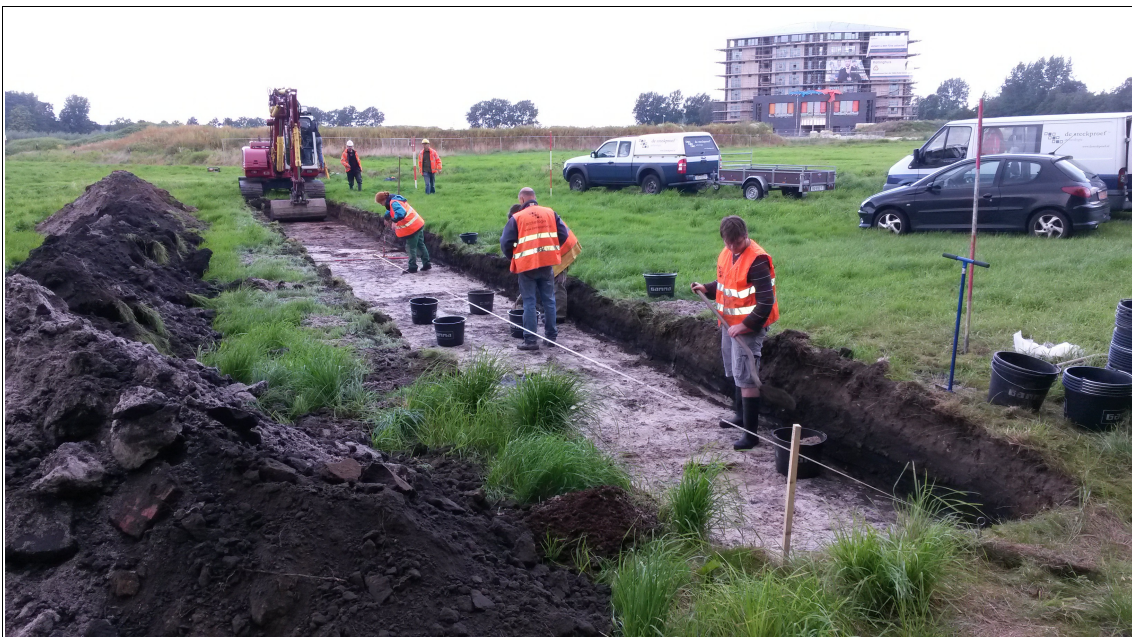
Figuur 3. Eelderwolde, Businesspark Ter Borch: Overzicht van de werkzaamheden in put 1. De zeefvakken zijn uitgezet en de bovenste 5 centimeter wordt uitgegraven.
