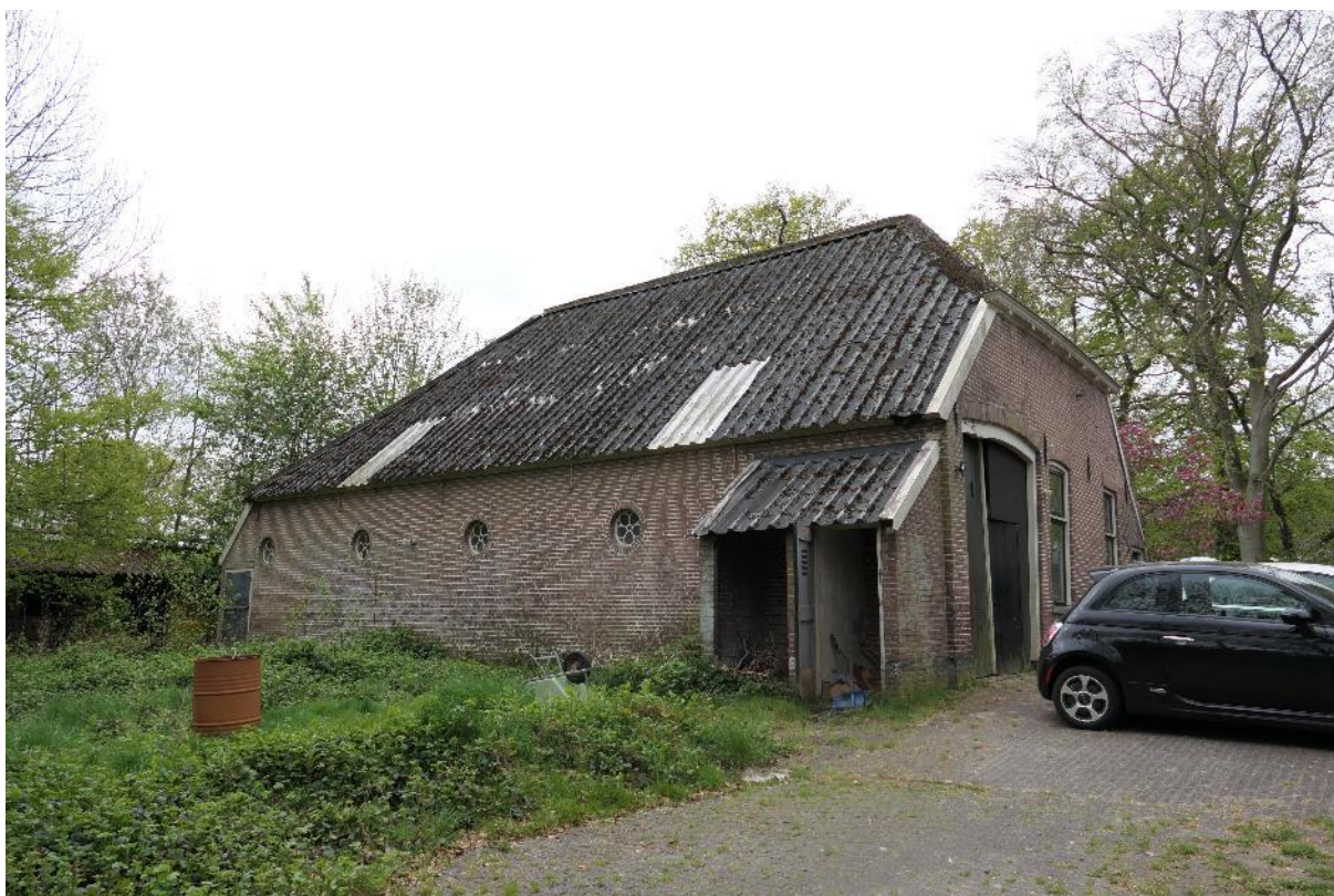
Figuur 2.5 De te slopen schuur.
