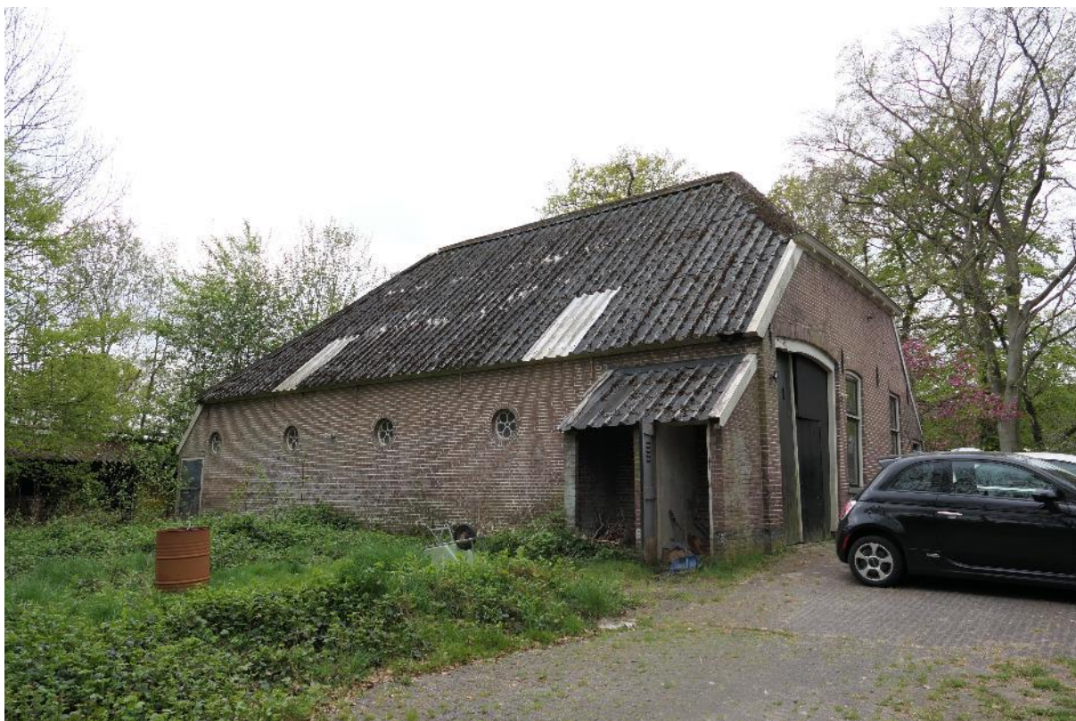
Figuur 1.5 De te slopen schuur.
