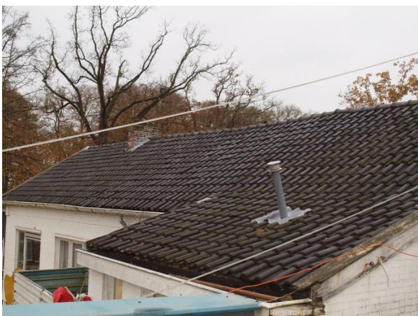
Figuur 4. Dak oriëntatie van het woonhuis richting noordoost.
