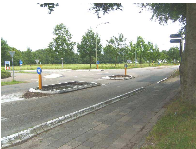
Figuur 3: Huidige T-splitsing Hoofdweg en de Meerweg (in zuidoostelijke richting)
