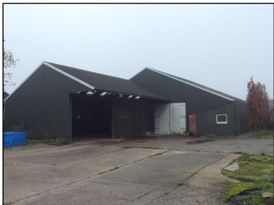
Foto 1 Schuur van damwandplaten
