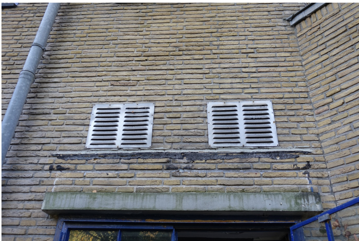
Via deze roosters kunnen vleermuizen het gebouw inkomen.
