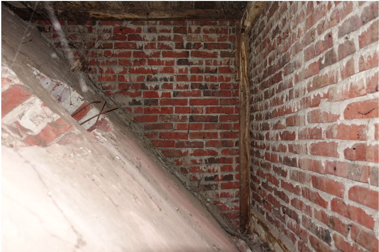
Potentiele overwinteringsruimte voor vleermuizen.
