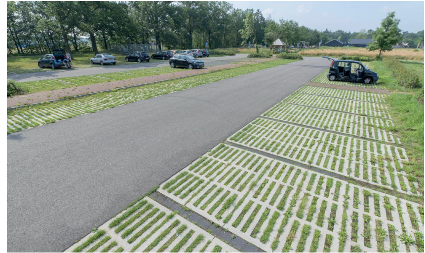
Parkeren op grasklinkers (SoliDrain S1, Swaans Beton).
