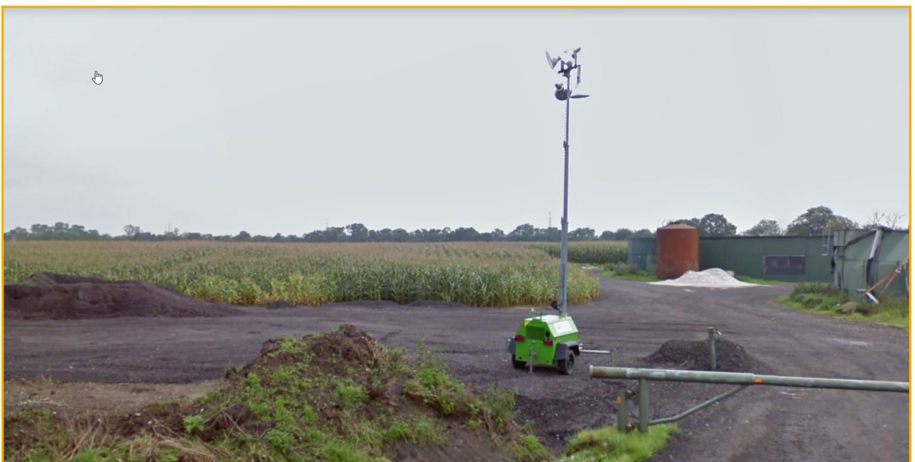
Figuur 3. Foto voor de aanleg van het nieuwe mestbasin (Bron: Google streetview)
