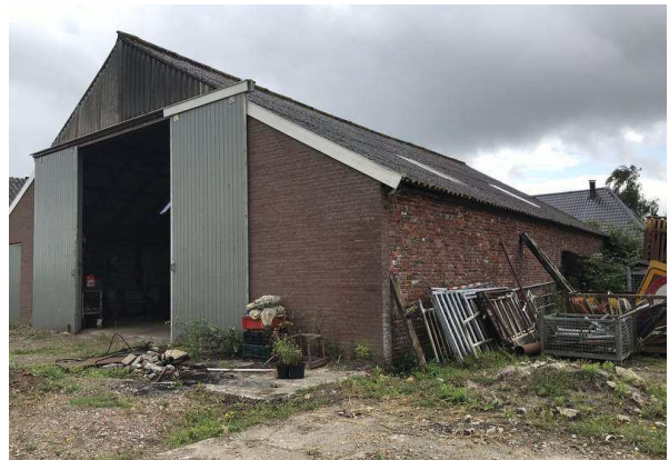
Figuur 4. Overzicht plangebied, de meest westelijke schuur. Foto genomen richting het zuidoosten.
