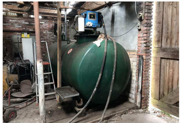
Figuur 9. De gierkelder loopt door tot onder de dieseltank.
