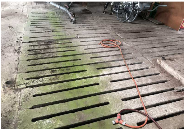
Figuur 7. Zicht op de gierkelder in de westelijke schuur, met de betonnen ventilatieroosters.
