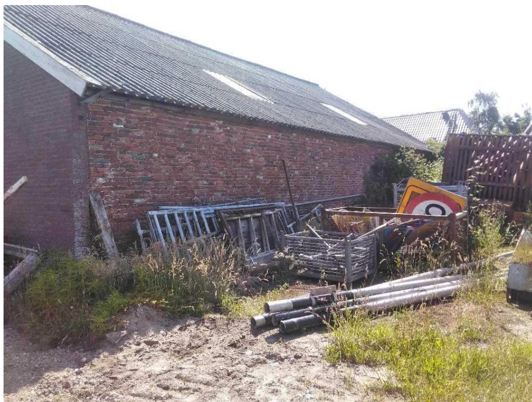
Foto 1. Westzijde schuur Pelincksweg 1B.
