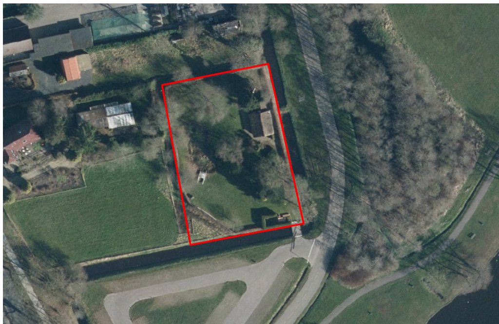
Figuur 2. Recente luchtfoto plangebied met projectgrens (rood).
