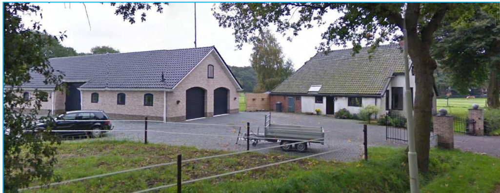
De schuur, de te slopen woning en het hekwerk in één oogopslag
