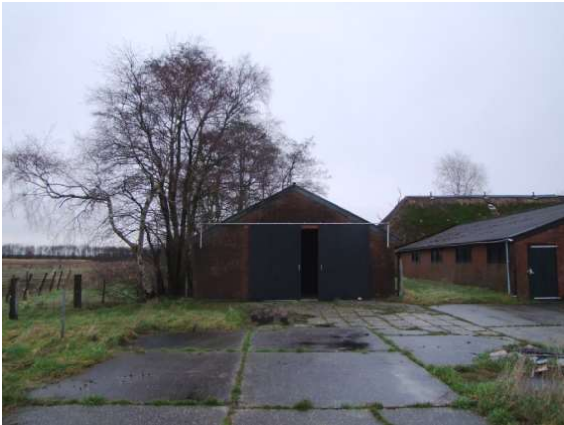
Figuur 2-3. Meest westelijke te slopen schuur, met hiernaast de te rooien bomenrij.
