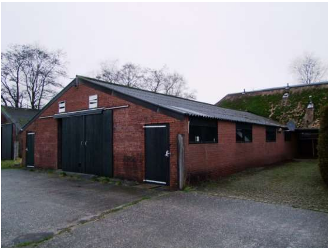
Figuur 2-4. Meest oostelijke te slopen stal.
