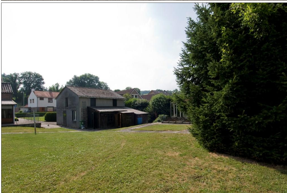
Foto's bestaande situatie
