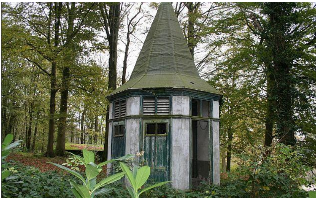
toiletgebouw ten oosten van het Emmaüs
