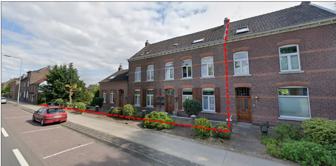
Foto's bestaande situatie (bron: Google Streetview)
