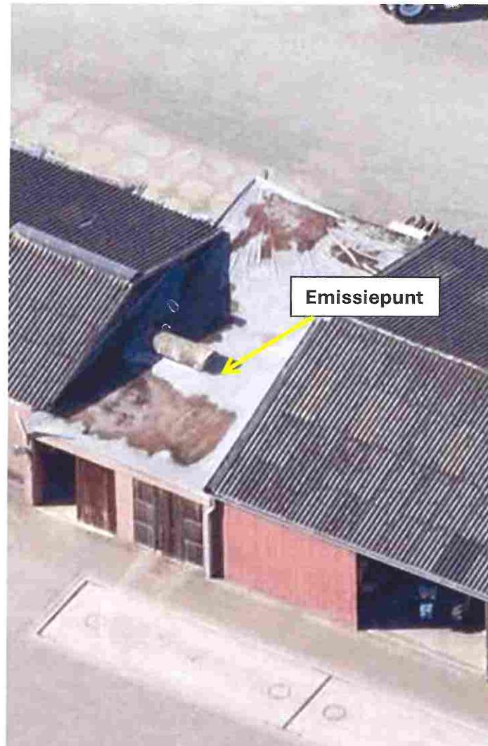
Rundveestal 2, ligging oost – west
