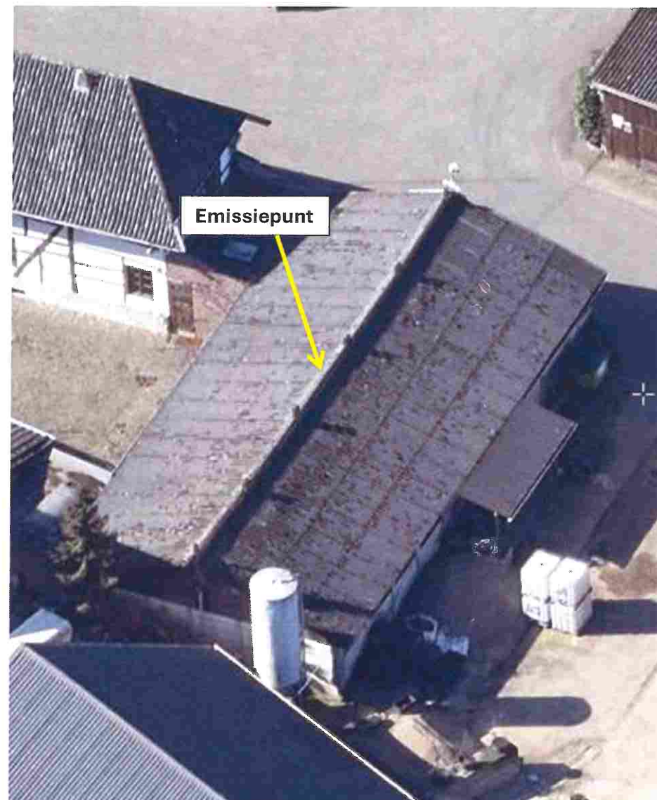
Rundveestal 1, ligging oost – west
