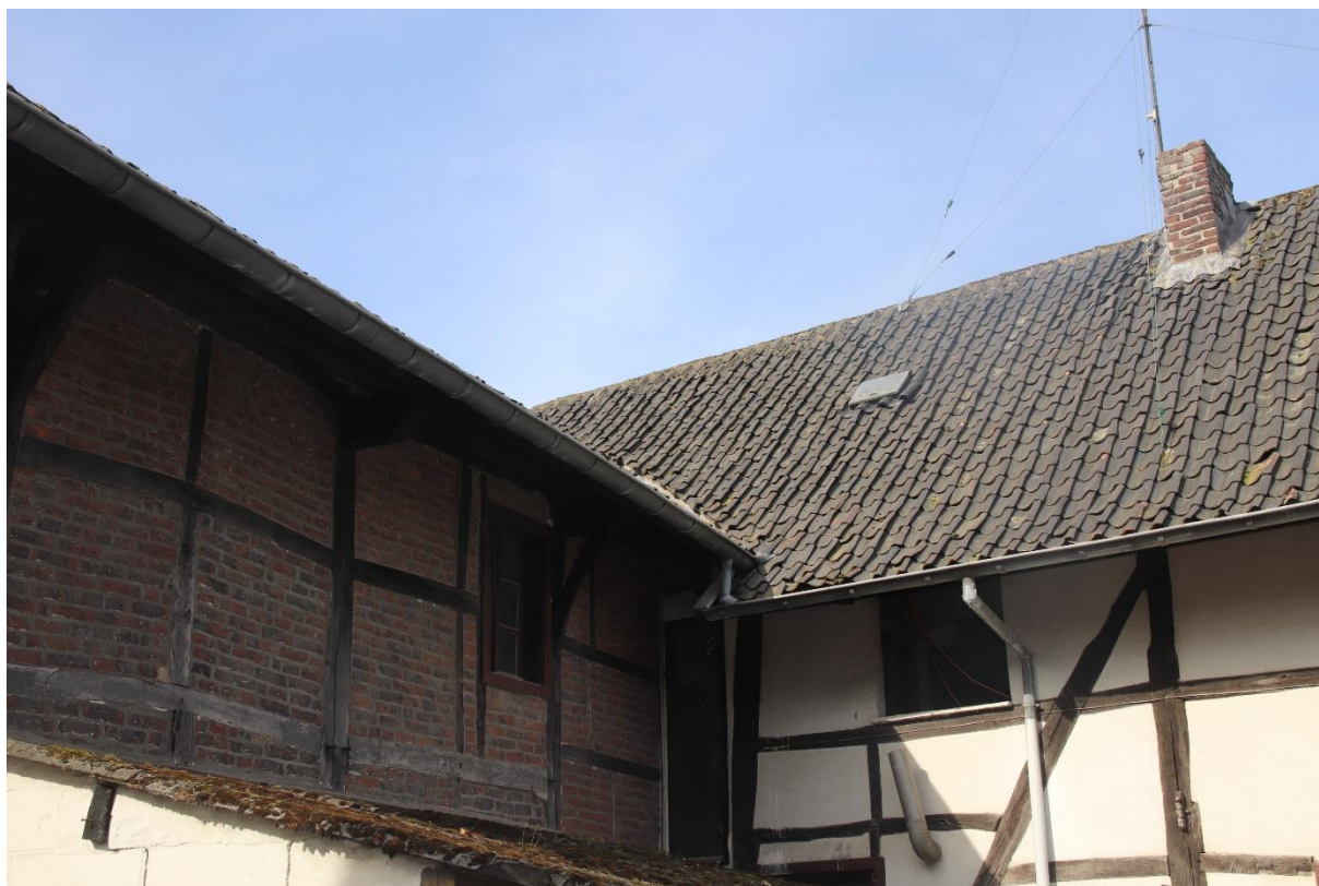
Foto 1: Beeld van een deel van de te renoveren bebouwing
