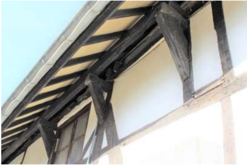
21. De uitkraagschoren van de vierde en vijfde travee...
