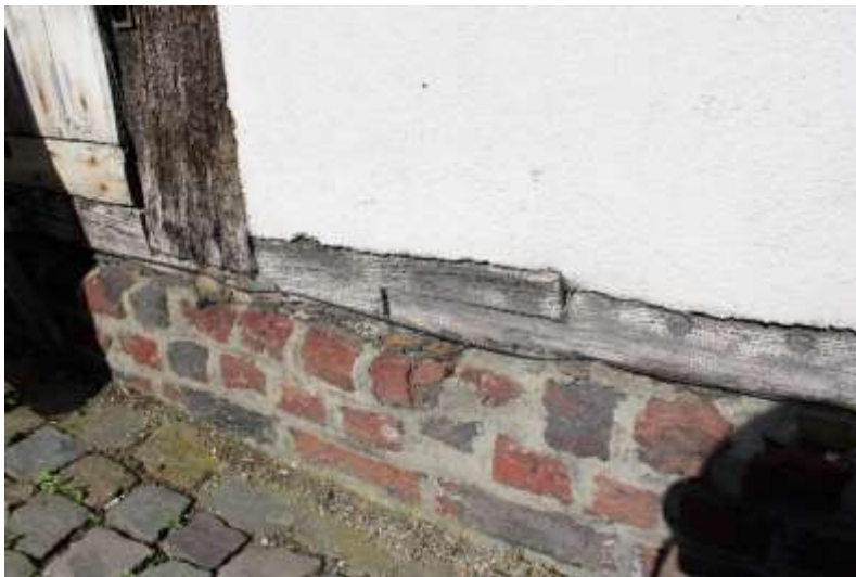
64. De kopgevel 65. Detail van de voetplaat bij de secundair gemaakte toegang
