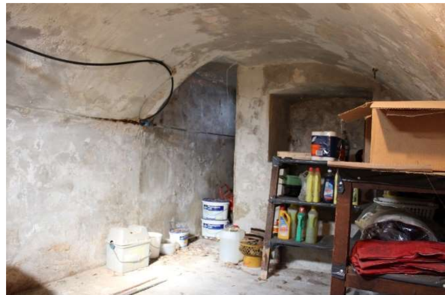
47. De kelder, gezien richting westen
