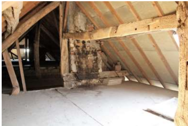
40. De balk tussen beide nokstijlen, opnieuw met halfhoutse kepingen
