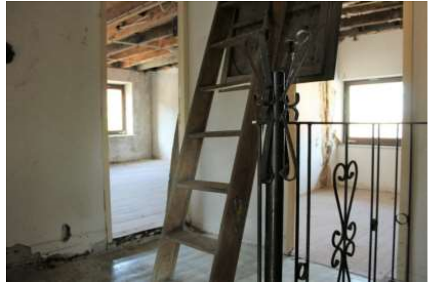
32. De overloop gezien richting zuidwesten
