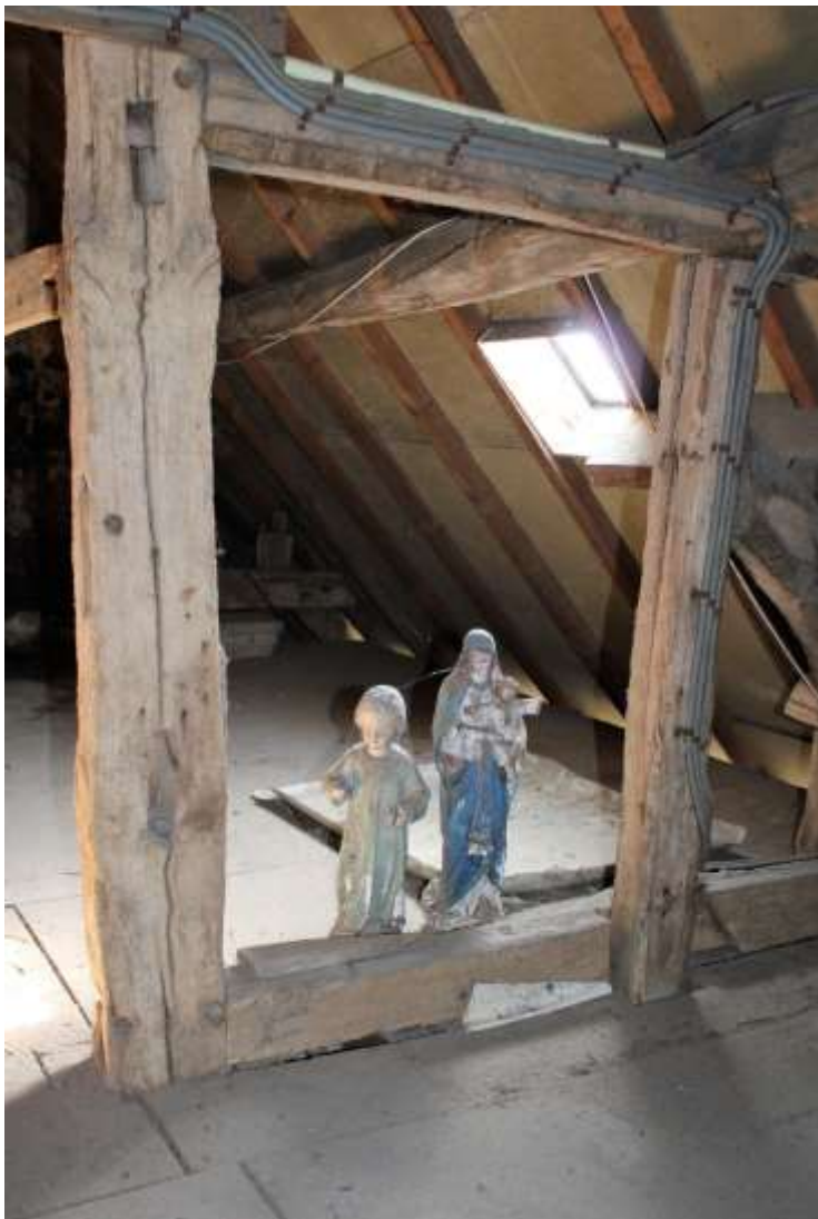
39. het gebint tussen de tweede en derde travee, met oudere stijl en horizontale gebintbalk (bemerkt ook de halfhoutse keping)
