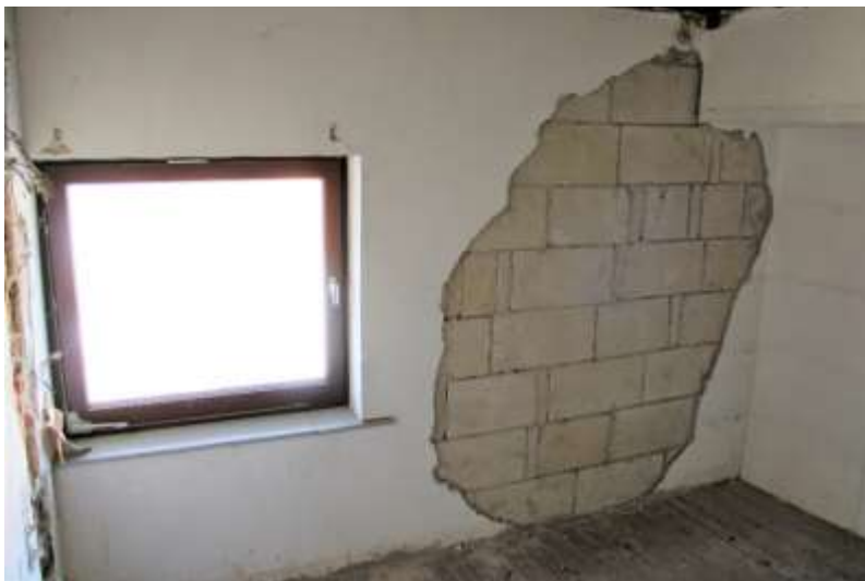
35. De kamer aan de westzijde, met binnenblad uit gasbetonblokken
