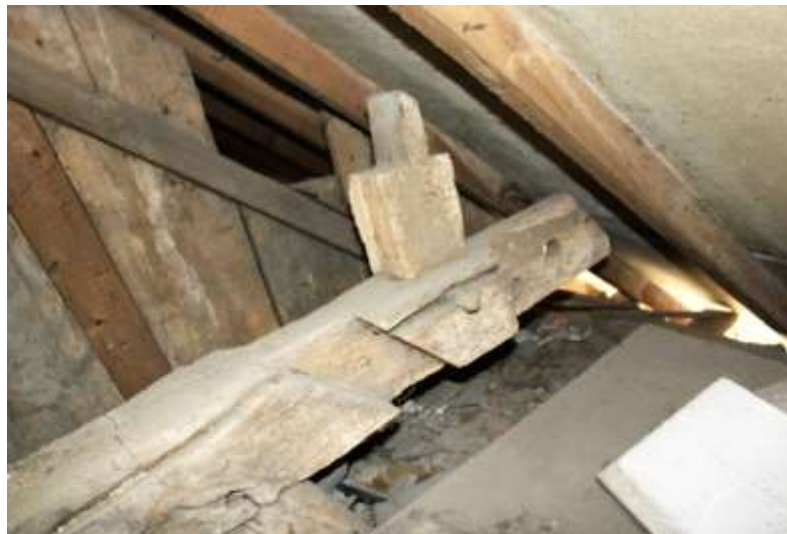
41. De spantbalk met lange pen aan het uiteinde. Ook hier weer een halfhoutse keping
