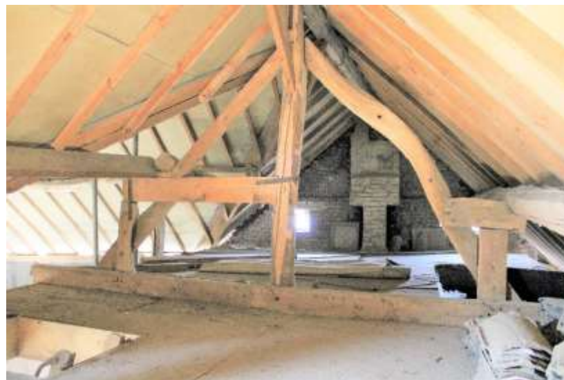
37. Blik richting straatgevel met het kaspant tussen travee een en twee
