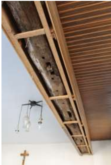
25. Blik op de voorkamer 26. Detail van de ankerbalk die oorspronkelijk deel uitmaakte van het kopgebint, ofwel de vakwerkgevel aan de straat
