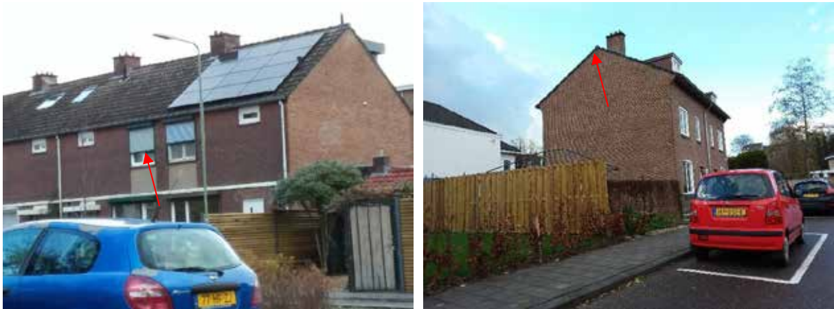
Figuur 3.1 Weergave in-/uitvlieglocaties van de gewone dwergvleermuis, namelijk een rolluik (links) en nokdakpan (rechts). Verblijfplaatsen van deze soort bevinden zich met name onder nok-/kantdakpannen.
