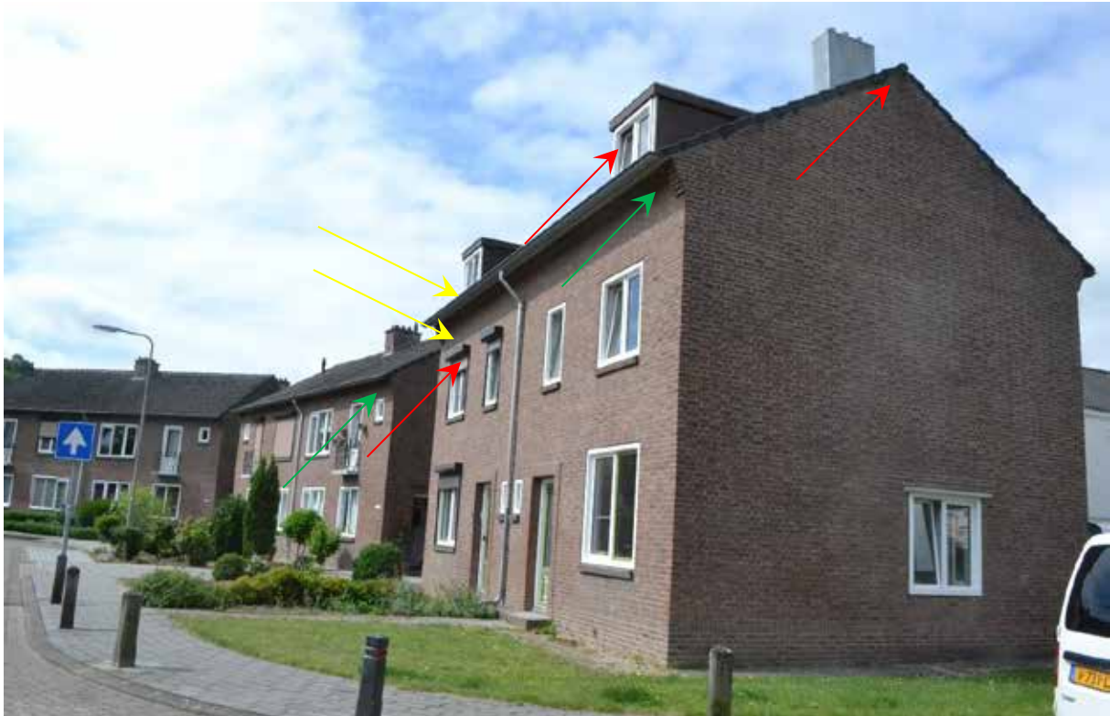
Figuur 3.2 Wooncomplex C6: Locatie van de mogelijke rust- en/of voortplantingslocaties van vleermuizen en gierzwaluw bij de rode pijl. Ter plaatse van de gele pijl kunnen huismussen broeden. De huiszwaluw heeft nesten ter plaatse van onder andere de groene pijl.
