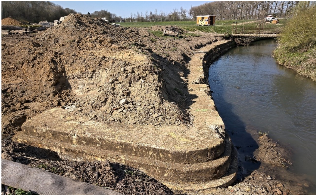
Figuur 12: De aangetroffen kademuur binnen plangebied Oude Geularm. 20
