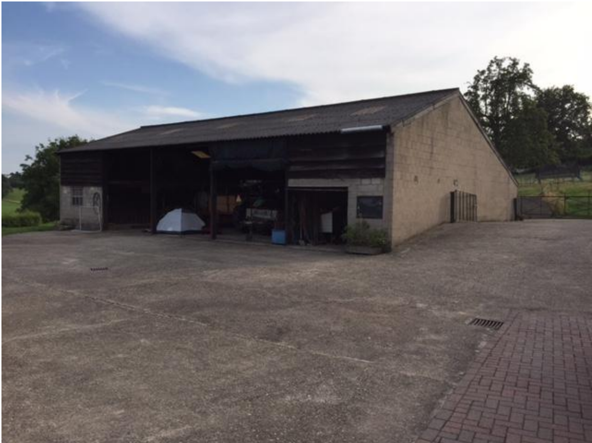
Figuur 1.2 Situatie plangebied ter plaatse van de werktuigenloods, dit gebouw wordt gesloopt.
