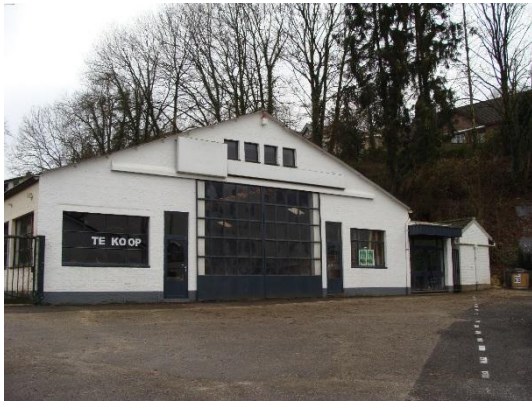
Figuur 3: Voorzijde voormalig metaalconstructie-bedrijf Bogers. De streeplijn rechts vormt de grens van het perceel.
