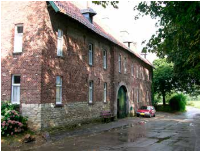
1. De straatgevel: links de sokkel van het vakwerkpand met de versterking uit 1630/39, daarnaast de poort en de aanpalende vleugel uit 1663. Boven de poort bevindt zich een verzekeringsplaatje van de OBWM (Onderlinge Brand en Waarborg Maatschappij)
