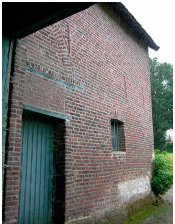
22. De achterzijde van de schuur met de dichtgezette poort
