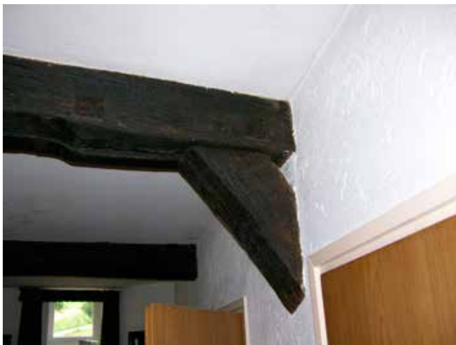
10. In de woonkamer bevindt zich nog een moerbalk met korbeel uit de 16de eeuwse vakwerkconstructie
