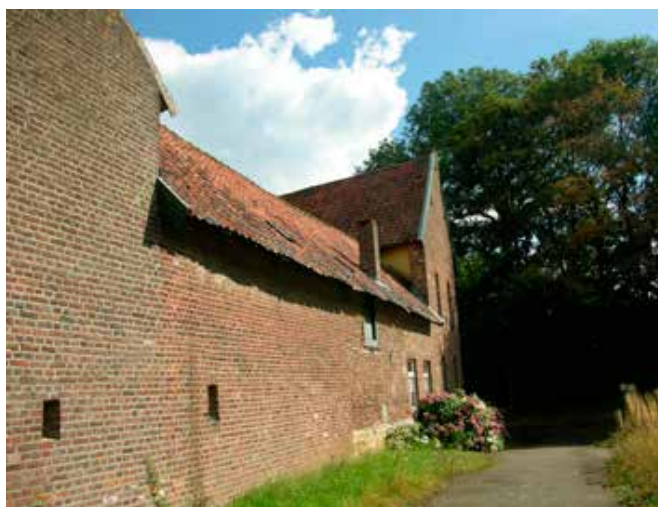
3. De zijgevel en het eerste stuk van de haakse vleugel zijn vrij recent vervangen door nieuw metselwerk. Boven het dak van de aanbouw is een gepleisterd stuk van de 16de eeuwse vakwerkgevel te zien. In de vleugel zijn, na het keukengedeelte, de versterking uit de 17de eeuw, de verlenging uit het midden van de 18de eeuw en de topgevel van de schuur uit de 18de eeuw te zien
