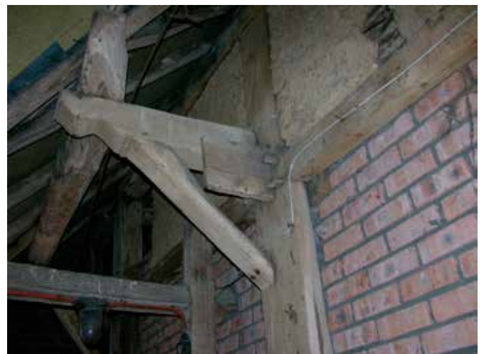
11. De achterzijde van het woonhuis met het 16de eeuwse vakwerk
