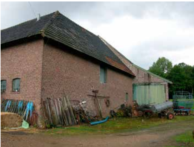
26. Op de voorgrond de hoek van de nieuwe stalvleugel uit 1911, op de achtergrond de topgevel van de oude schuur en de latere zijbeuk
