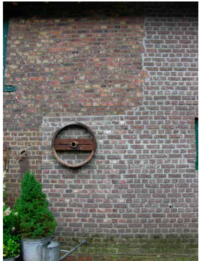
17. Diverse fases in het metselwerk. Rechts is vrij recent helemaal vervangen
