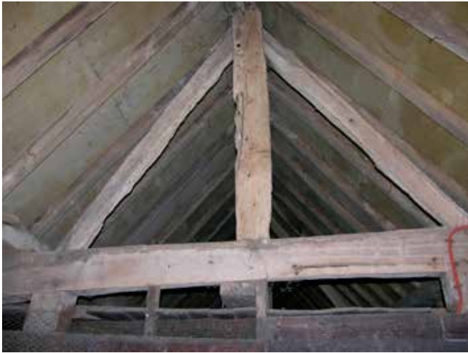
20. Deel van de constructie
