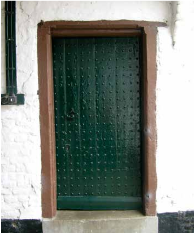
8. De spijkerdeur met de oorspronkelijke kloppergreep in de originele omlijsting met vellingkant en kapelletjes
