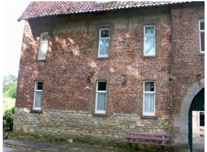
2. De versteende gevel van het woonhuis. Rechts boven in de hoek onder het dak zit nog een restant van het oorspronkelijke gladde voegwerk uit de bouwtijd. Alle vensters zijn vernieuwd, inclusief de omlijsting in het metselwerk
