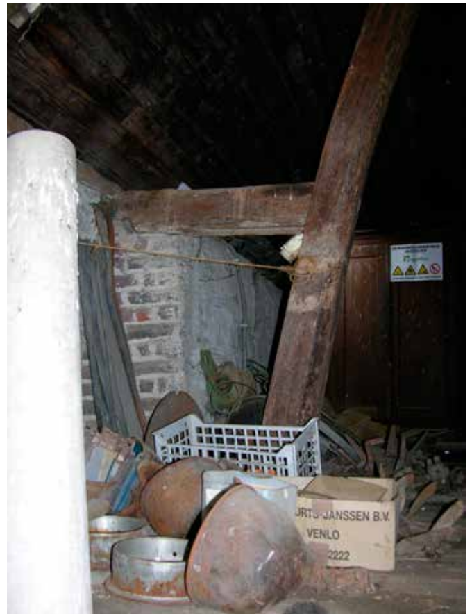
19. Een van de spantbenen van de 18de eeuwse kapconstructie, met aantasting door ammoniak die verder het hout heeft geconserveerd
