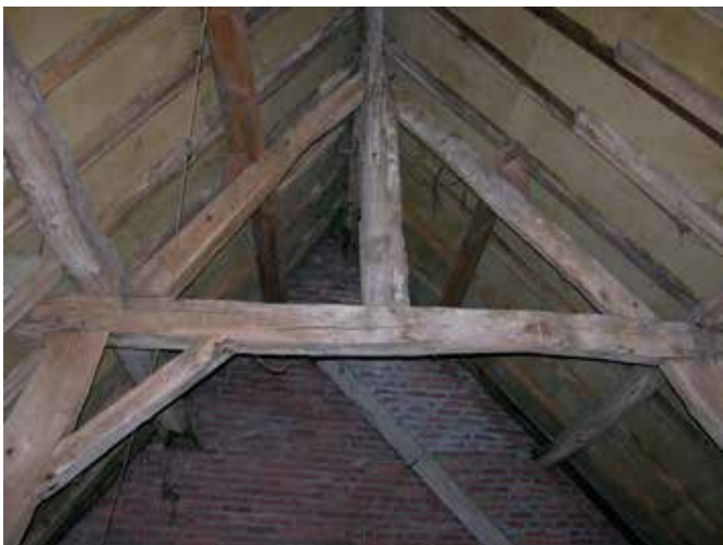
14. Dat is ook op te maken uit de gebruikte nokondersteuning
