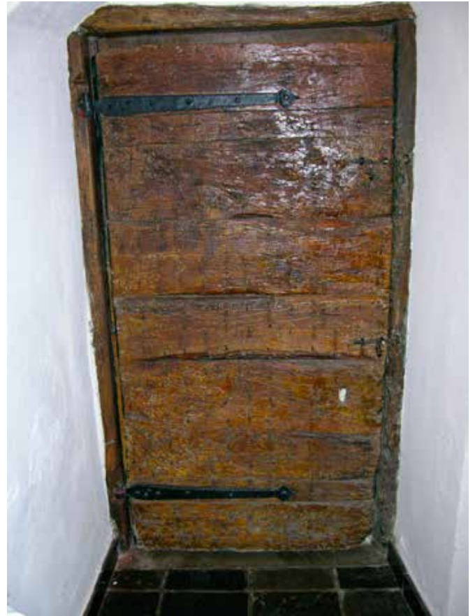
9. De deur aan de binnenzijde. Goed te zien zijn de omgeslagen gesmede spijkers
