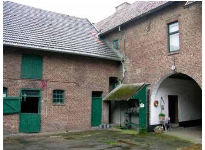
31. De aansluiting op de woonhuisvleugel aan de straat
