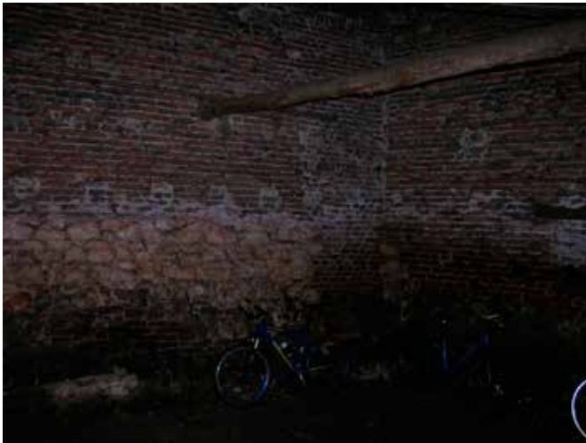
24. Aan de binnenzijde is een deel van het oude blad in mergel bewaard gebleven. De roze verkleuring van de mergel verwijst naar de brand
