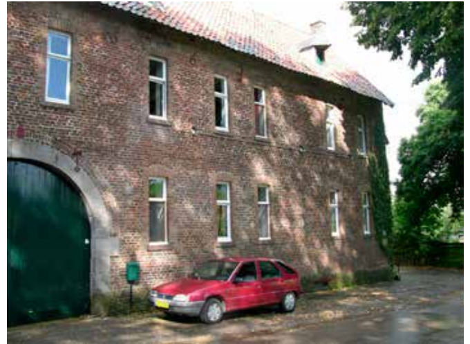
5. De vleugel uit 1663. Alle vensters zijn vernieuwd, maar vervangen oorspronkelijke halve kruiskozijnen
