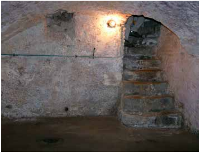
12. De kelder onder de 17de eeuwse aanbouw haaks op het oude huis
