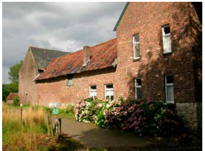
15. De zijgevel met de fases van de vleugel
