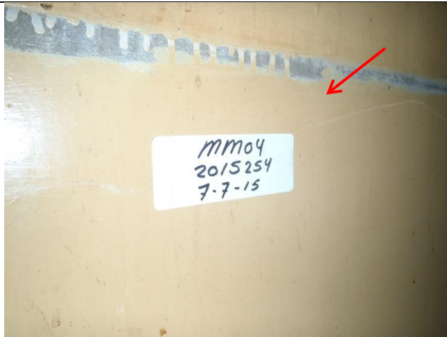
Foto nr. 15 en 16: Wandbeplating
