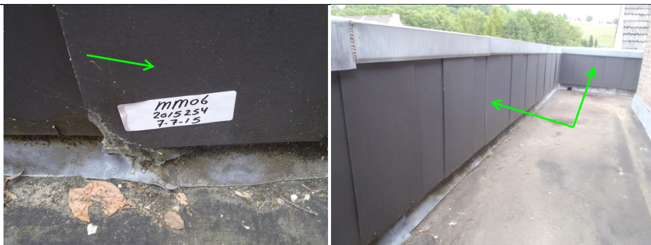
Foto nr. 19 en 20 : Plaatmateriaal
