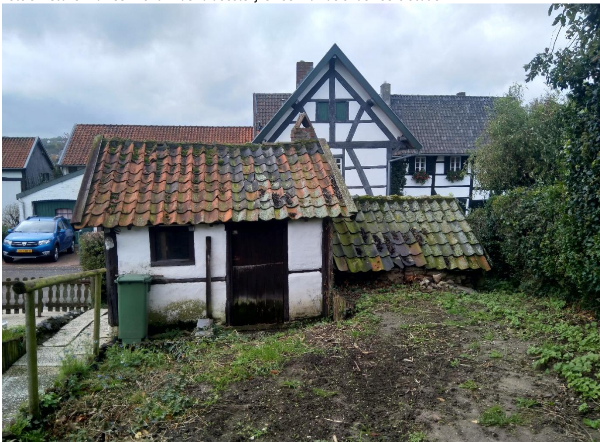
Foto 6: Het oude schuurtje op de onderzoekslocatie kijkend naar de oostelijke gevels.
