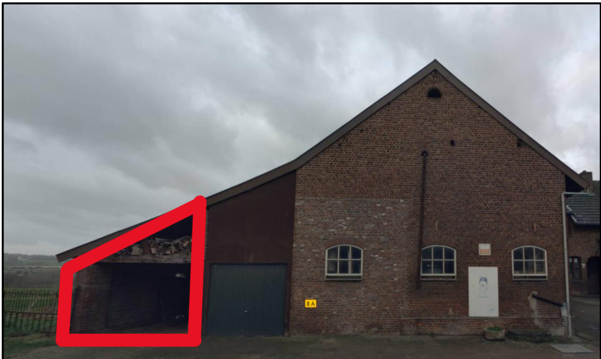
Afbeelding 12. Te saneren afdeling.
