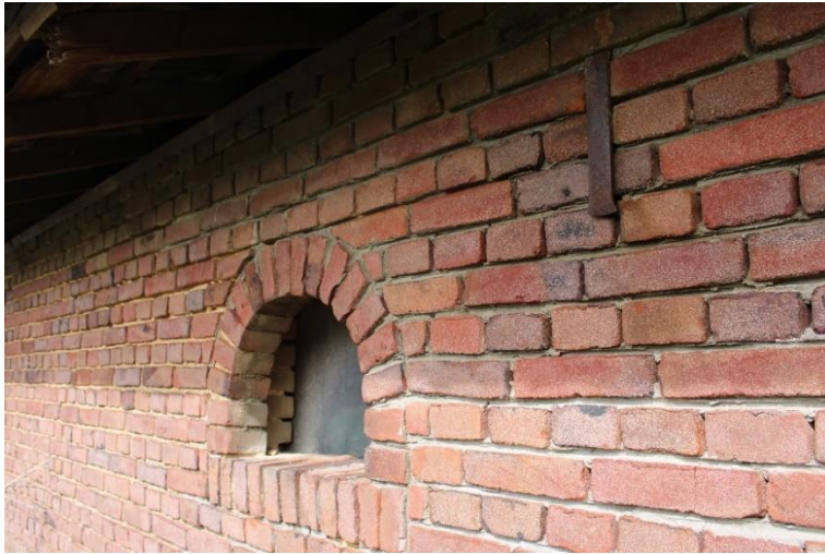
10. Detail van de rode bezande vormbaksteen
