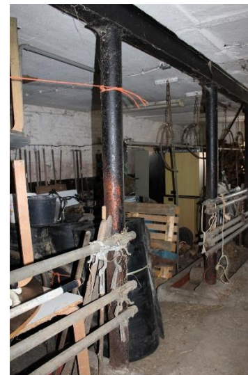
17. De stal gezien in westelijke richting 18. De ijzeren kolommen met onderslagbalk uit 1967
