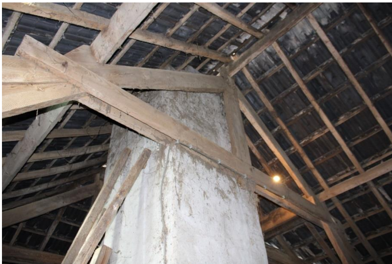
33. Eén van de spanten van het 'verbeterd Hollands' type, met de kenmerkende dubbele hanebalken
