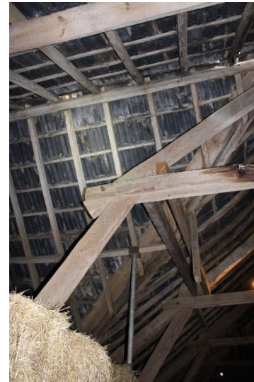
34. Het weggezaagd spantbeen bij de aansluiting met de andere vleugel
