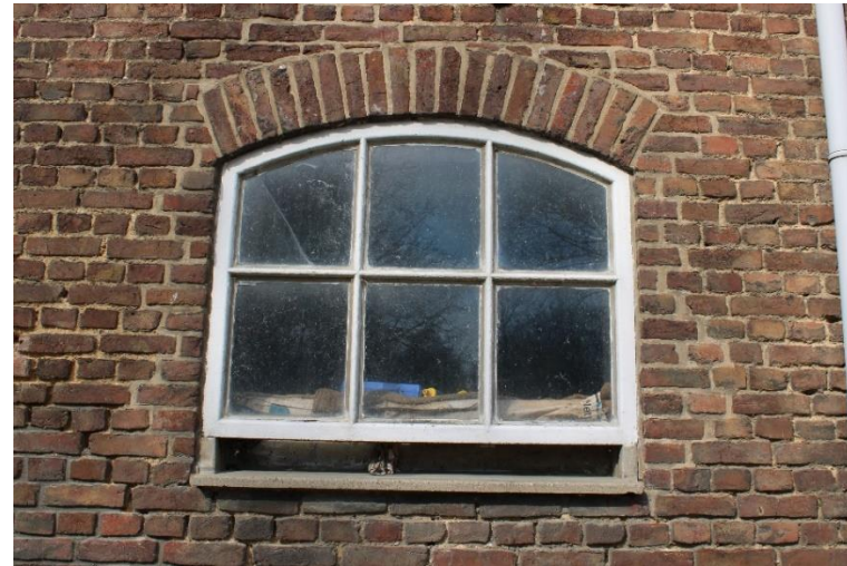
Een schokbeton stalraam in de oostgevel
