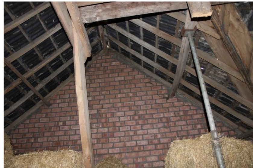
36. De aldaar in 1983 in porisoblokken opgetrokken scheidsmuur t.b.v. het transformeren van de stal tot woning
