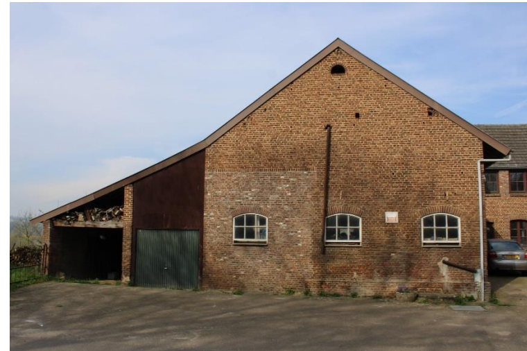
1. De oostelijke kopgevel
