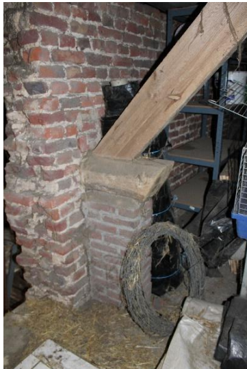
32. Detail van een van de met het maken van de betonnen vloer weggezaagde spantbalken (/trekplaten)
