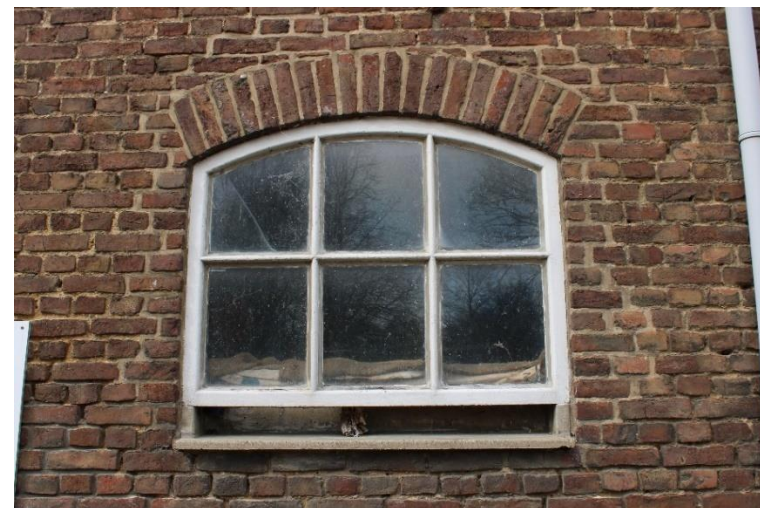
2. De evident secundaire schokbeton stalramen met ventilatiesleuf
