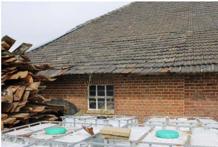
11. De latere uitbreiding aan de zuidoostzijde. Bemerkt de bouwnaad
