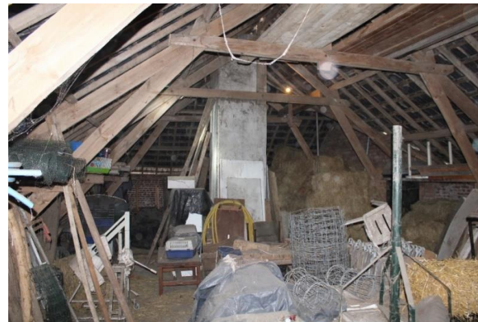
31. De zolder van het hoofdvolume, eveneens gezien in westelijke richting
