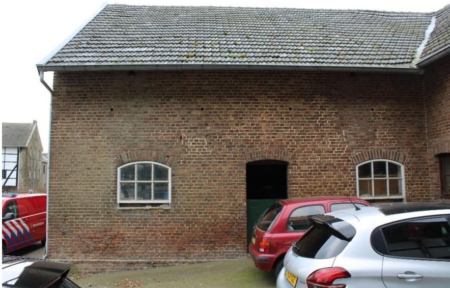
↑6. Blik op de noordgevel, met centraal de oorspronkelijke toegang →7. De aaneenhechting met de in 1983 tot woning herbestemde stalvleugel
