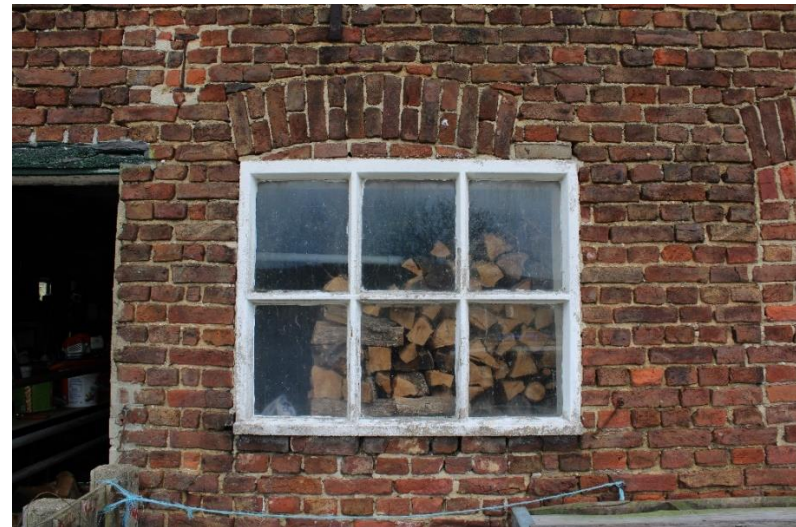
16. Detail van een secundair schokbeton stalraam
