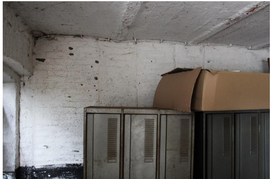
21. De ventilatiekoker, welke thans bovendaks is afgesloten 22+23. De gedichte openingen bij de aansluiting bij de andere stalvleugel
