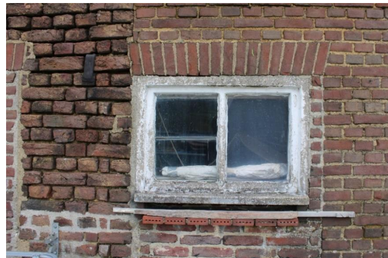
13. Detail van een duidelijk secundair schokbeton stalraam
