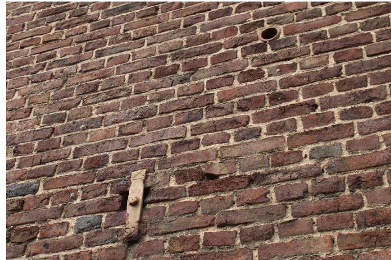
4. Detail van een van de ankerijzers en ontluchtingsschachtjes
