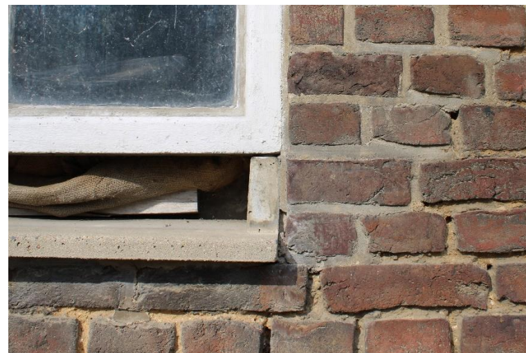
Detail van stopverf en voegwerk
