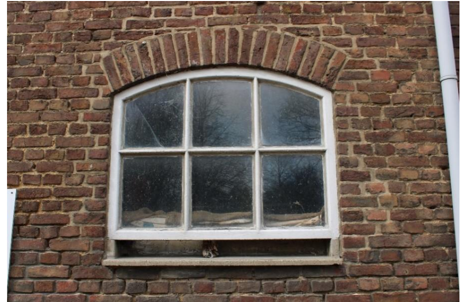
VIII. Eén van de schokbeton stalramen
