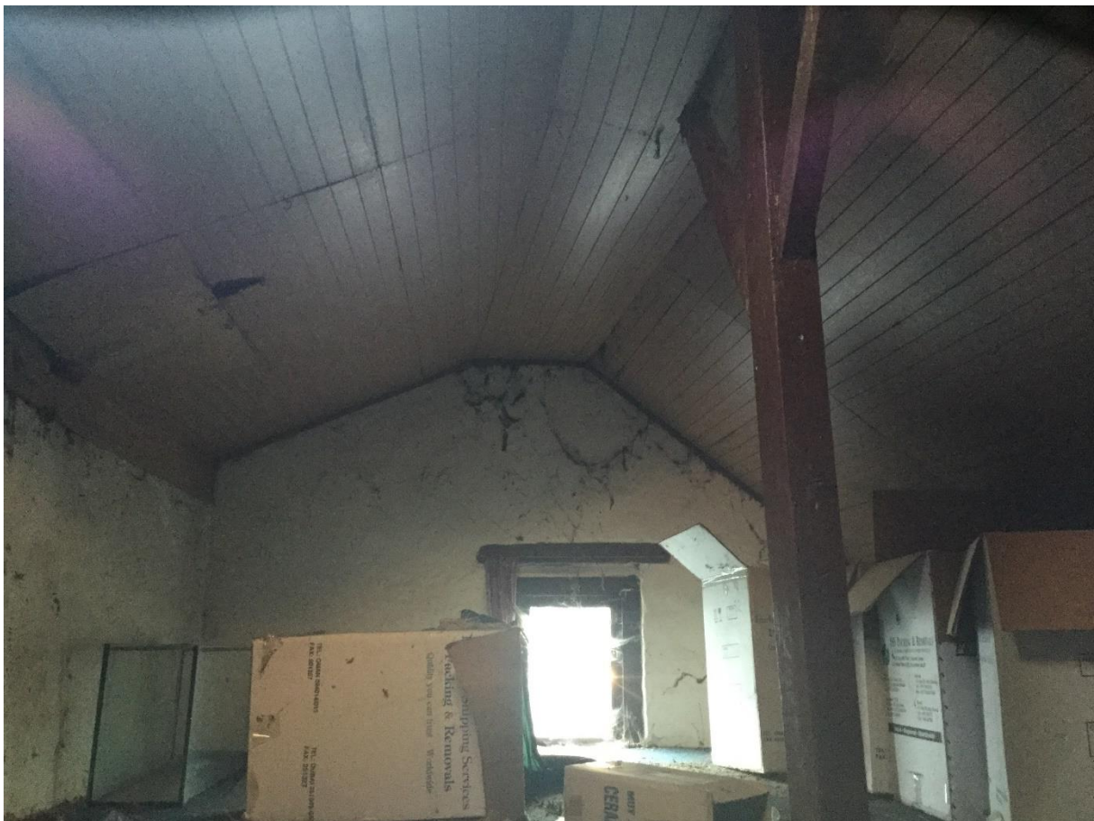
Figuur 3.1 Impressie van de zolder. De balken zijn geschikt als hangplek. Echter elders in het dak bevinden zich meerdere gaten en de bovenramen bezitten geen ruiten waardoor het erg tochtig is. Tijdens de check met warmtebeeldcamera zijn geen aanwijzingen (uitwerpselen en hangende vleermuizen) van vleermuizen waargenomen.
