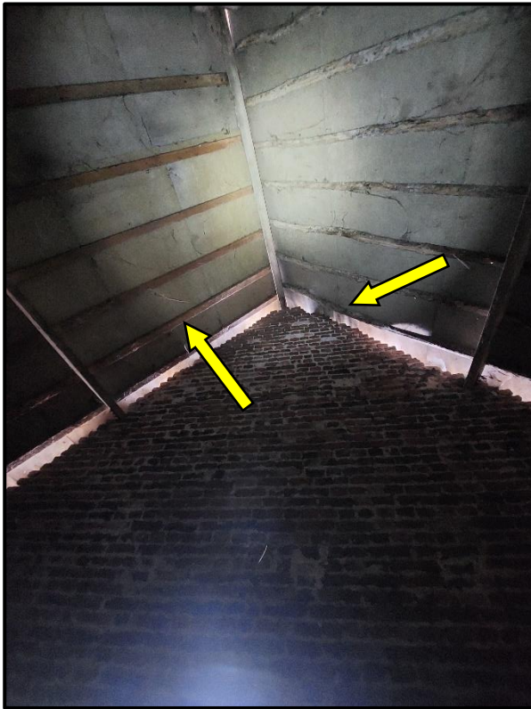
Figuur 5.1 Links: de situatie van de onderzijde van het dak met zichtbaar het dakbeschot (aangegeven met gele pijl). Rechts: situatie van de boeiboorden met ruimte (zie gele pijlen) tussen de muur waar vleermuizen zich kunnen vestigen.
