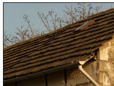
Figuur 5. Pannendak woonhuis.
