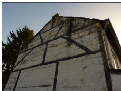
Figuur 6. Noordzijde zijgevel woonhuis.
