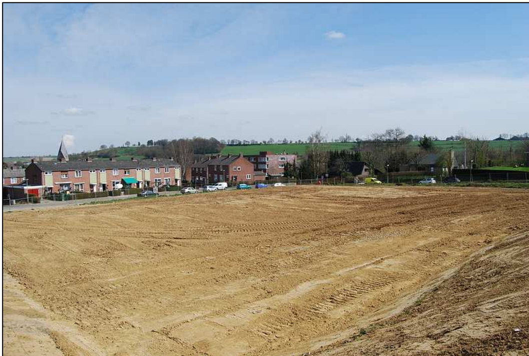
Afbeelding 6. Situatie na sloop (zicht op Willem Beekmanstraat)
